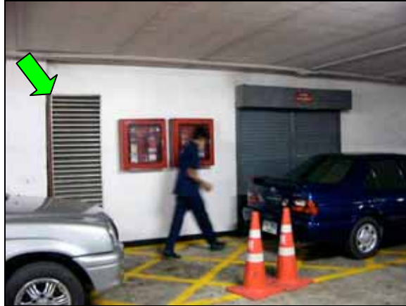
ด้านหน้าห้องและบานเกล็ดระบายอากาศ
