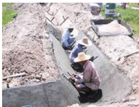
ภาพที่ 6 การคาดคอนกรีตในช่วงโค้งตามแนวเขตแปลงกรรมสิทธิ์
