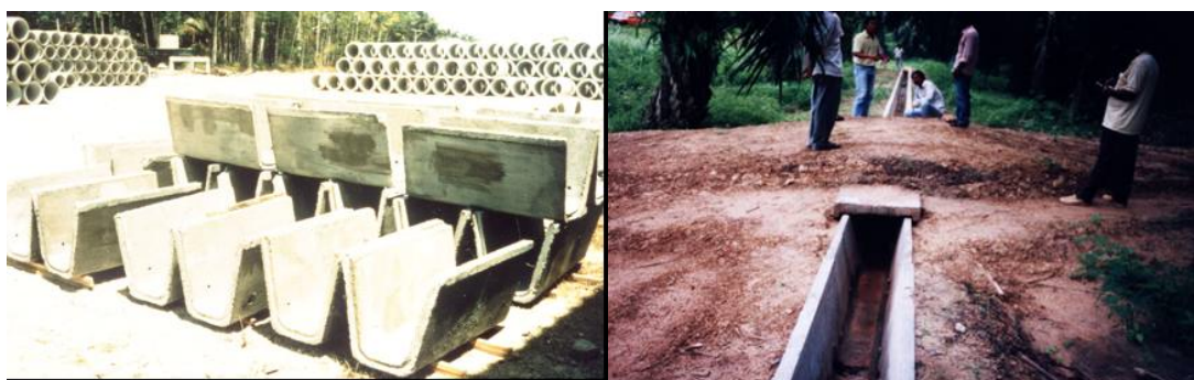
ภาพที่ 8 คูส่งน้ำแบบรางคอนกรีตเสริมเหล็กสำเร็จรูป
