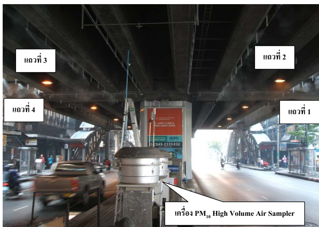
ภาพที่ 8 ระบบฉีดละอองน้ำแรงดันสูงที่ประกอบด้วยหัวฉีด (Nozzle) จำนวน 4 แถว
