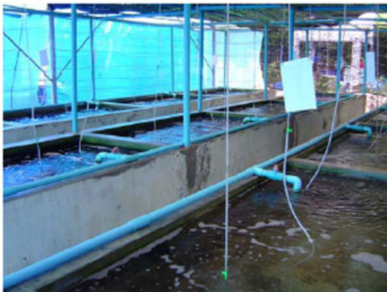
บ่อคอนกรีตสำหรับเลี้ยงพ่อแม่พันธุ์หอยเป่าอื้อ
