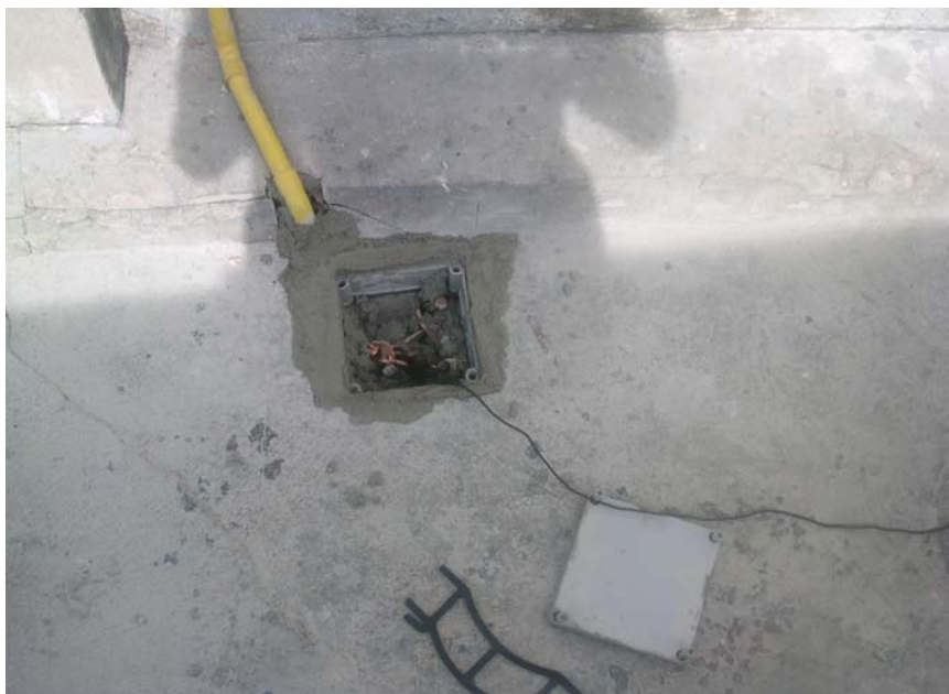
ภาพที่ 58 แสดงการติดตั้งสายดิน
