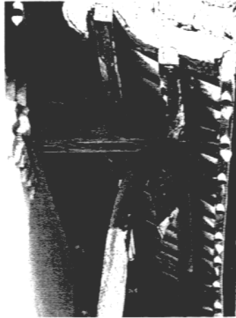
ความชำรุดเสื่อมโทรมของโครงสร้างเครื่องบนไม้ของพระอุโบสถ
