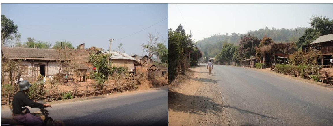
ภาพที่ ๗-๘ สภาพถนนหน้าหมู่บ้านขบลัง เมืองสีป้อ บันทึกภาพ ๘ มีนาคม ๒๕๕๗
