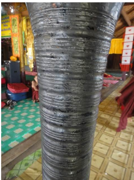
ภาพที่ ๔๖๑ การบากรอยลูกแก้วลงบนทางกลอง วัดจ๋ามเผือก
