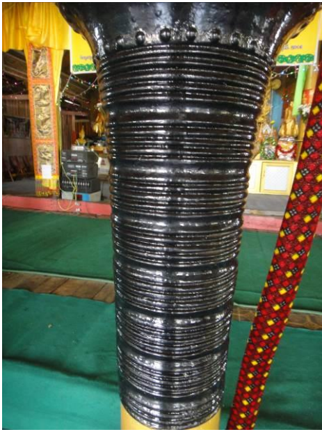
ภาพที่ ๔๕๓ การตอกหมุดก่อนขึ้นรอยบากควั่น ลูกแก้ว
