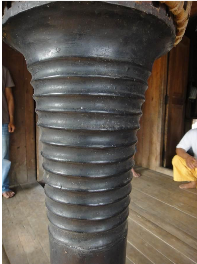
ภาพที่ ๓๒๒ แสดงการควั่นบากรอยลูกแก้วจากฐานโหลงสู่อวกลองบ้านนางจำ
