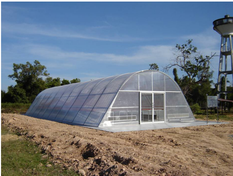
รูปที่ 3.8 ระบบอบแห้งแบบกรีนเฮาส์ที่องค์การบริหารส่วนตำบลหัวเรือ อำเภอเมือง จังหวัดอุบลราชธานี
