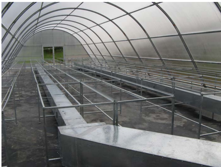
รูปที่ 3.2 ชั้นวางผลิตภัณฑ์และท่ออากาศภายในระบบบอบแห้ง
