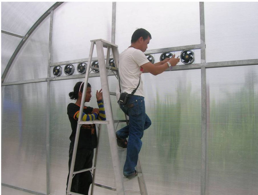
รูปที่ 3.4 พัดลมไฟฟ้ากระแสตรงขนาด 12V ใช้กระแส 1.2 A
