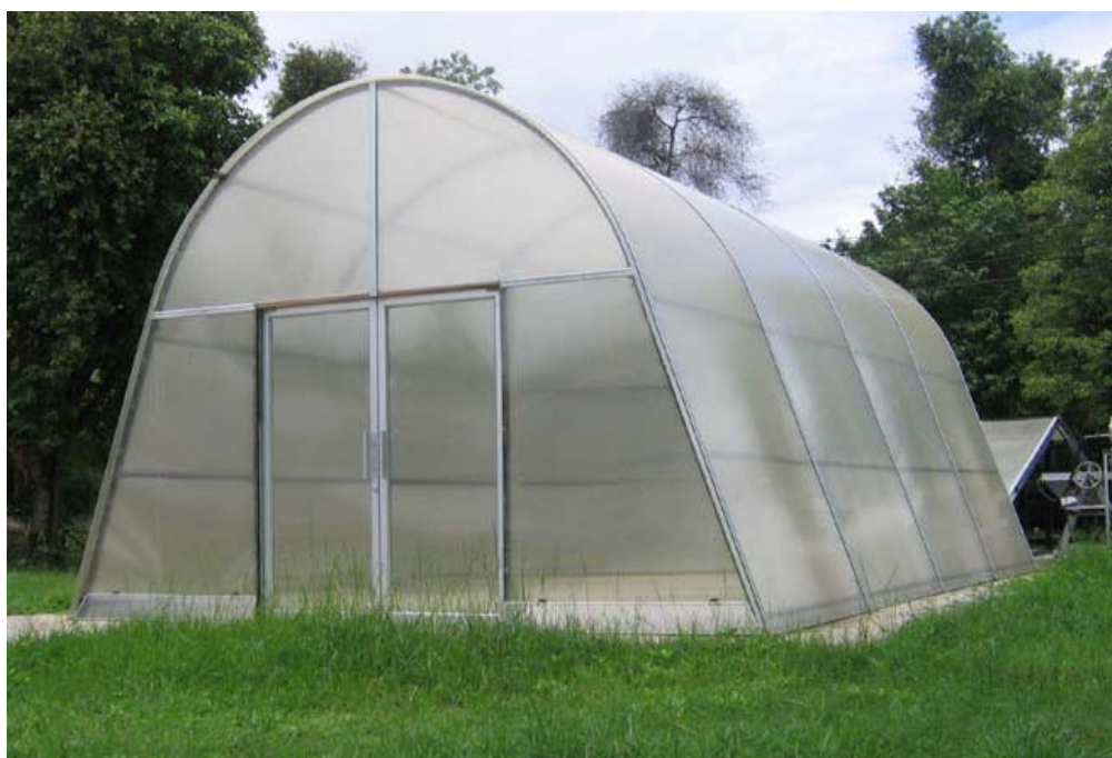
รูปที่ 2.26 ระบบอบแห้งแบบกรีนเฮาส์ที่สามารถถอดประกอบได้ พัฒนาโดย Janjai และคณะ (2009)
