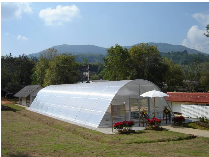
รูปที่ 3.7 ระบบอบแห้งแบบกรีนเฮาส์ที่โครงการอันเนื่องมาจากพระราชดำริ บริษัท อุตสาหกรรมการเกษตรเขาค้อ จำกัด อำเภอเขาค้อ จังหวัดเพชรบูรณ์
