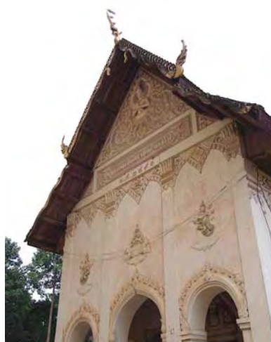
ภาพที่ 178 แสดงส่วนบน กรอบหน้าบัน โหง่ ตัวรวย วัดบุญญานุสรณ์ ตำบลหมากหญ้า อำเภอหนองวัวซอ จังหวัดอุดรธานี
