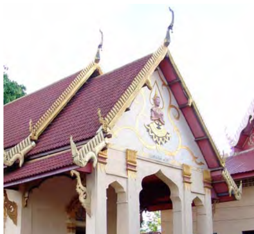
ภาพที่ 185 ตัวอย่างการเปลี่ยนหลังคาใหม่ พร้อมกับช่อฟ้าแบบภาคกลาง ที่วัดโพธิ์ศรีไสยสะอาด ตำบลหนองบุ อำเภอเมือง จังหวัดอุตรธานี
