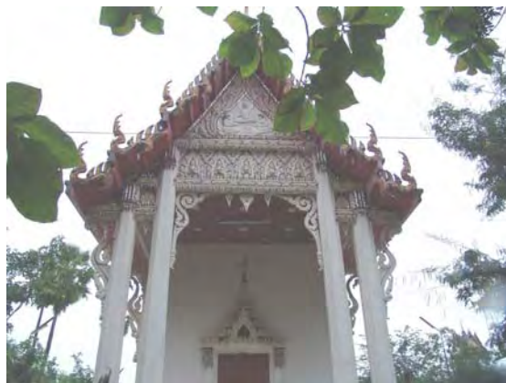
ภาพที่ 314 เครื่องบนทำเป็นเครื่องลายของมีนาคสะดุ้ง หางหงส์ งวงไอยรา ตามแบบแผนรวมถึงแผแร่ ตัวอย่างวัดศุภาราม อำเภอเมือง จังหวัดมหาสารคาม
