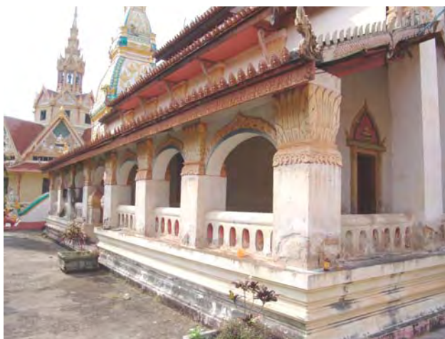
ภาพที่ 104 แสดงภาพลูกกรงระเบียง วงโค้งระหว่างหัวเสาและฐาน รูปแบบอิทธิพลฝีมือช่างญวน ที่วัดพระแท่น บ้านแดง ตำบลบ้านแดง อำเภอพิบูลย์รักษ์ จังหวัดอุดรธานี
