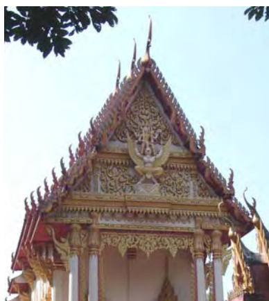
ภาพที่ 291 การประดับนารายณ์ทรงครุฑที่กรอบหน้าบัน วัดป่าศรีคุณาราม อำเภอกู่แก้ว จังหวัดอุดรธานี โครงสร้างเสาตุ๊กตาหลอกและด้านข้างช่องอดูปีกนก
