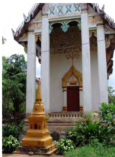
ภาพที่ 381 ช่างสกลนิยมทำเสาเหลืยมย้อมุม ที่เสาหรณรรองรับน้ำหนักรองสร้าง ตัวอย่างที่วัดโพธิ์ธาราม อำเภอสว่างแดนดิน จังหวัดสกลนคร
