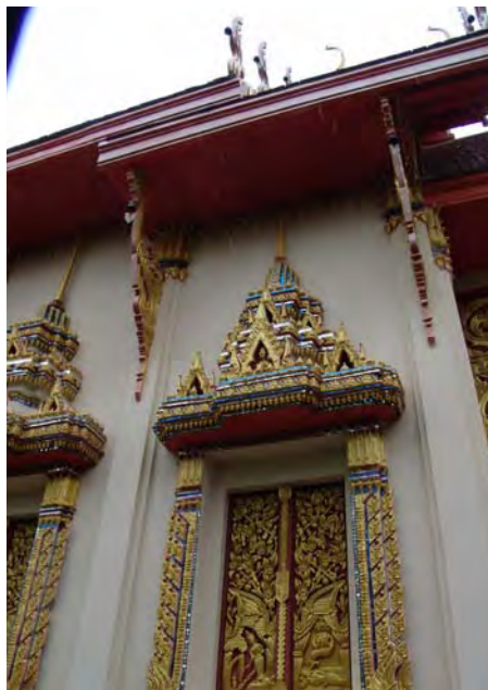
ภาพที่ 328 วัดปัจฉิมทิศ อำเภอมือง จังหวัดมหาสารคาม ที่ใช้แบบมาตรฐานจากกรม ซึ่งแบบจาก กรมการศาสนาเป็นซุ้มบันแถลง แต่รูปแบบที่ปรากฏเป็นซุ้มยอด
