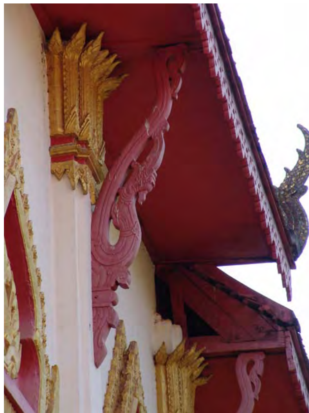
ภาพที่ 130 คันทวยรูปหัวนาคแกะสลักด้วยไม้ ที่วัดสุริยาราม บ้านเชียงพิณ ตำบลเชียงพิณ อำเภอเมือง จังหวัดอุดรธานี
