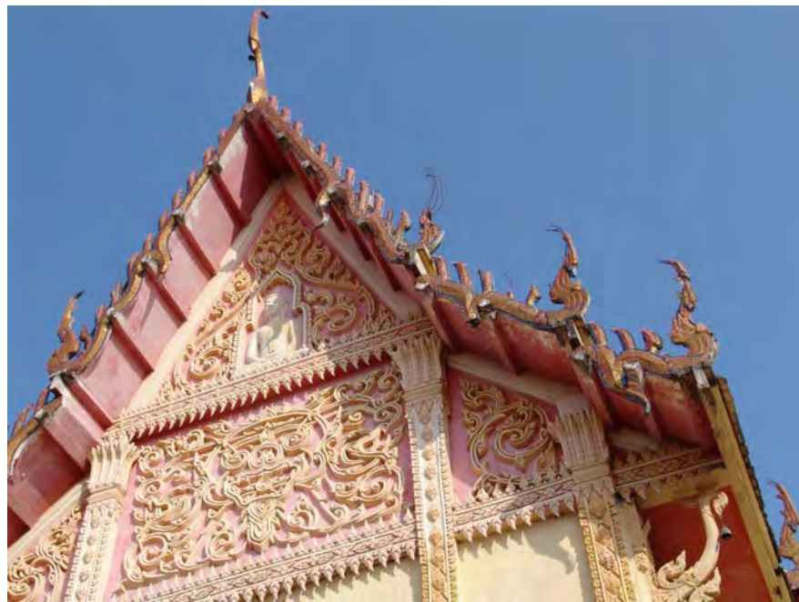
ภาพที่ 493 โครงสร้างแบบช่อประธานใช้เสาดูกตาหกลกแบ่งพื้นที่ ตัวอย่างที่วัดโพธิ์ชัยศรี อำเภอเมือง จังหวัดอุดรธานี
