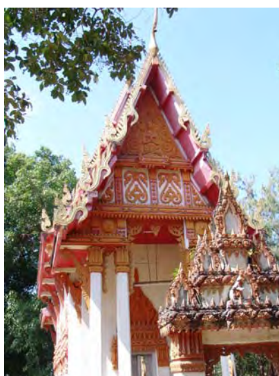
ภาพที่ 590 โครงสร้างชื่อเอกพาดบนหัวเสาพบ ตัวอย่างที่วัดสว่างอรุณ อำเภอโนนสะอาด จังหวัดอุดรธานี
