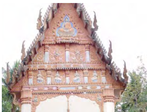
ภาพที่ 295 การใช้แปหัวเสาแทนการใช้เชิงกลอน สะพานหนูและตีนผี ตัวอย่างที่วัดสุภาवास อำเภอบ้านผือ จังหวัดอุดรธานี
