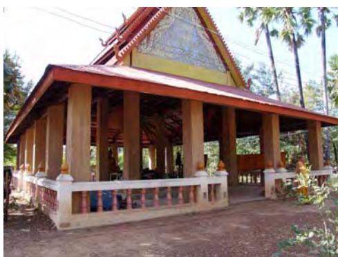
ภาพที่ 213 ตัวอย่างสิมโปรงวัดทุ่งสว่างปะโค อำเภอกุมภวาปี จังหวัดอุดรธานี ปัจจุบันเปลี่ยนแปลงหลังคาและเสา
