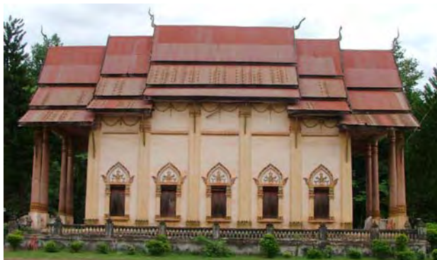
ภาพที่ 118 แสดงภาพด้านข้าง หลังคาทำซ้อน 3 ซ้อน 3 ตับ ช่อฟ้า 6 ตัว ที่วัดโยธานิมิตร ตำบลหนองขอนกว้าง อำเภอเมือง จังหวัดอุดรธานี (ภาพถ่ายเก่า)
