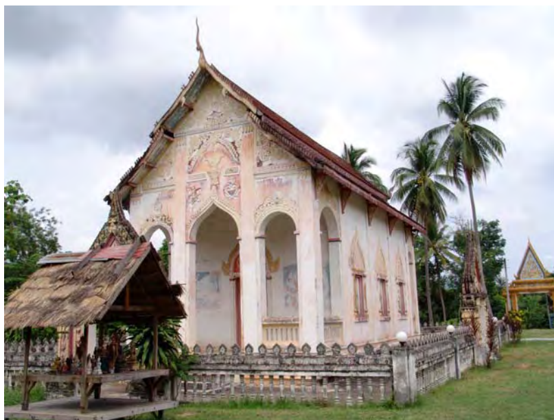
ภาพที่ 197 การใช้ผนังรับน้ำหนัก พัฒนาจากอิทธิพลช่างญวน พบโดยทั่วไป คู่กับการใช้เสาหอนแบบภาคกลาง ในจังหวัดอุดรธานี ตัวอย่างที่วัดหนองอ้อ อำเภอหนองวัวซอ จังหวัดอุดรธานี
