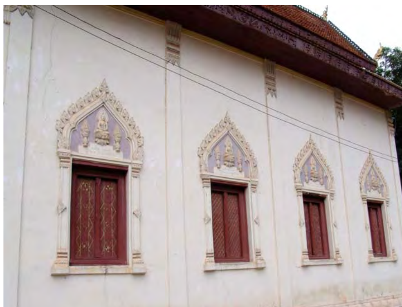
ภาพที่ 180 ตัวอย่างการใช้ผนังรับน้ำหนัก อิทธิพลช่างญวน ส่งผลให้คันทวยไม่มีส่วนเกี่ยวข้องในโครงสร้าง ที่วัดบุญญานุสรณ์ ตำบลหมากหญ้า อำเภอหนองวัวซอ จังหวัดอุดรธานี
