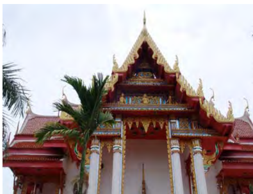
ภาพที่ 534 โครงสร้างหน้าบันแบบช่อเอกพาดบนเสาหอน ที่วัดศรีบุญเรือง อำเภอกุมภวาปี จังหวัดอุดรธานี
