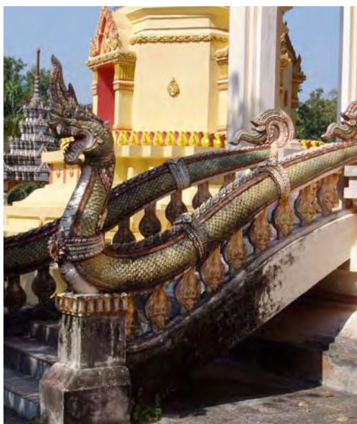
ภาพที่ 378 ลูกกรงประดับราวบันไดพบว่าเป็นแบบเฉพาะที่สร้างขึ้นด้วยเทคนิคหล่อถอดพิมพ์คอนกรีต ที่วัดธาตุสว่างโนนยาง อำเภอเมือง จังหวัดอุดรธานี
