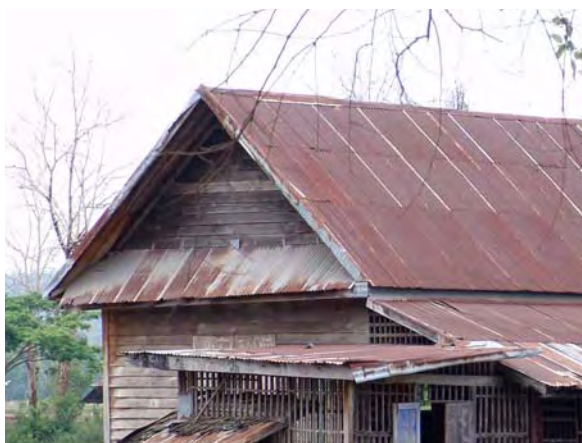
ภาพที่ 207 หลังคาทรงจั่ว มุงหลังคาสังกะสี วัดป่าหนองแขว ตำบลหมากหญ้า อำเภอนองวัวซอ จังหวัดอุดรธานี
