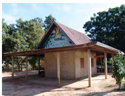
ภาพที่ 505 โครงสร้างเสารับน้ำหนักปีกนก แบบเสาเหลี่ยม ที่วัดบูรพา อำเภอนนสอาด จังหวัดอุดรธานี
