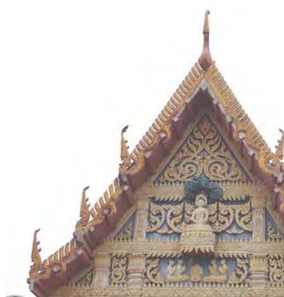
ภาพที่ 296 เชิงกลอนดับที่ 2 และ 3 นั้น มีแปเพิ่มขึ้นต่อจากแปวงเสมอ ตัวอย่างที่วัดบึงบ้านเสียว อำเภอมือ จังหวัดกาฬสินธุ์
