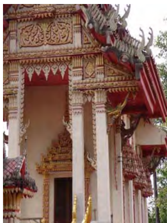
ภาพที่ 285 แสดงการประดับสหรัยในระบบโครงสร้างเสาเอกพาดบนหัวเสา ตัวอย่างที่วัดศรีมหาธาตุ อำเภอหนองหาน จังหวัดอุดรธานี
