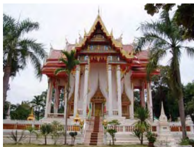
ภาพที่ 519 วัดศรีบุญเรือง อำเภอกุมภวาปี จังหวัดอุดรธานี ยกพื้นสูงภายในบริเวณกำแพงแก้ว
