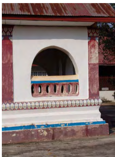
ภาพที่ 447 วงโค้งและการเจาะช่องวงรี ลักษณะเด่นเฉพาะของช่างญวน ที่วัดโนนสว่าง อำเภอพิบูลย์รักษ์ จังหวัดอุดรธานี
