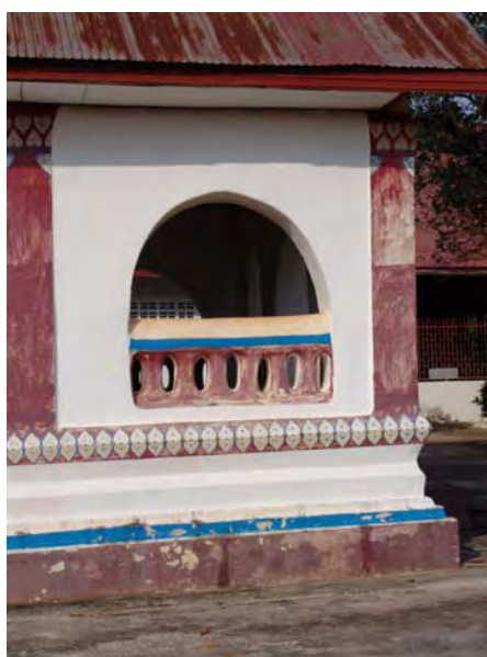
ภาพที่ 241 วงโค้งครึ่งวงกลม และวงรีรูปไข่ทางตั้ง ลักษณะเฉพาะร่วมฝีมือช่างฉนวน ที่วัดโนนสว่าง อำเภอพิบูลย์รักษ์ จังหวัดอุดรธานี
