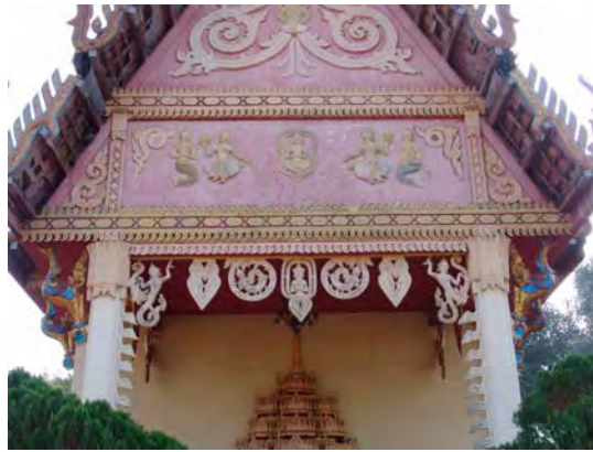
ภาพที่ 400 วัดท่าบ่อ อำเภอยะโยวาท จังหวัดอุดรธานี โครงสร้างแบบช่อประธานพาดบนหัวเสา
