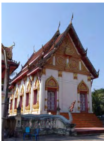
ภาพที่ 122 อุโบสถทรงโรง ก่อผนังทึบ เปลี่ยนโครงสร้างส่วนบนรวมถึงลวดลายประดับบางส่วน ที่วัดสุริยาราม บ้านเชียงพิณ ตำบลเชียงพิณ อำเภอเมือง จังหวัดอุดรธานี
