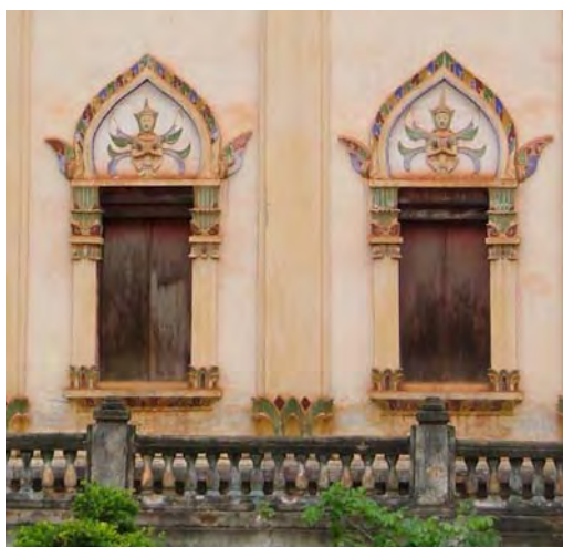
ภาพที่ 115 ซุ้มหน้าต่างทรงบันแถลงภายในประดับเทพนม และหัวเสากระเบื้อง มุมทางทิศเหนือที่วัดโยธานิมิตร ตำบลหนองขอนกว้าง อำเภอเมือง จังหวัดอุดรธานี ปัจจุบันรื้อสร้างใหม่ พ.ศ.2550 (ภาพถ่ายเก่า)
