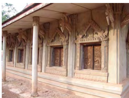
ภาพที่ 504 โครงสร้างเสารับน้ำหนักปีกนก แบบเสากลมที่วัดบวรพา อำเภอนนสอาด จังหวัดอุดรธานี
