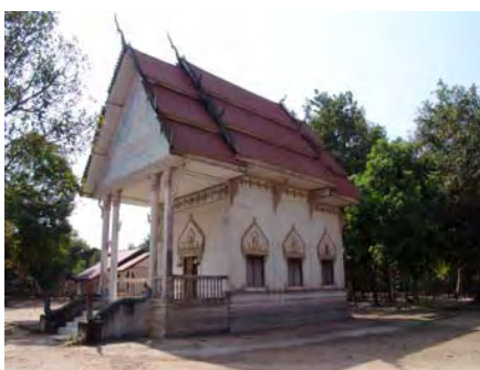
ภาพที่ 258 อุโบสถวัดอุดมมหารธรรม บ้านดงผักเทียม อำเภอสว่างคอม จังหวัดอุดรธานี สร้างในปีพ.ศ. 2529
