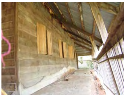
ภาพที่ 83 การเจาะช่องหน้าต่างโดยรอบด้านข้าง ที่วัดโนนพระ บ้านสงเปลือย ตำบลเสอเพลอ อำเภอกุมภวาปี จังหวัดอุดรธานี
