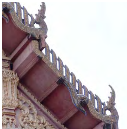
ภาพที่ 608 เครื่องล่ายองพบว่าทั้ง 3 วัดที่เป็นกลุ่มตัวอย่างมีการทำรอยต่อเนื่องกันโดยการใช้ตีนผี ซึ่งเป็นระเบียบของการก่อสร้าง ตัวอย่างที่วัดเกียรติไพบูลย์ อำเภอกุมภวาปี จังหวัดอุดรธานี
