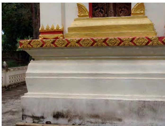
ภาพที่ 581 ฐานบัวของงานช่างร้อยเอ็ด ไม่มีรูปแบบเฉพาะแสดงให้เห็น ตัวอย่างที่วัดนิลาราม อำเภอบ้านผือ จังหวัดอุดรธานี
