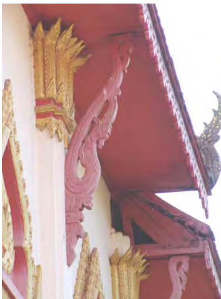
ภาพที่ 124 บัวหัวเสาแบบบัวแวง คันทวยเป็นรูปนาคดั้งเดิม ที่วัดสุริยาราม บ้านเชียงพิณ ตำบลเชียงพิณ อําเภอมือง จังหวัดอุดรธานี
