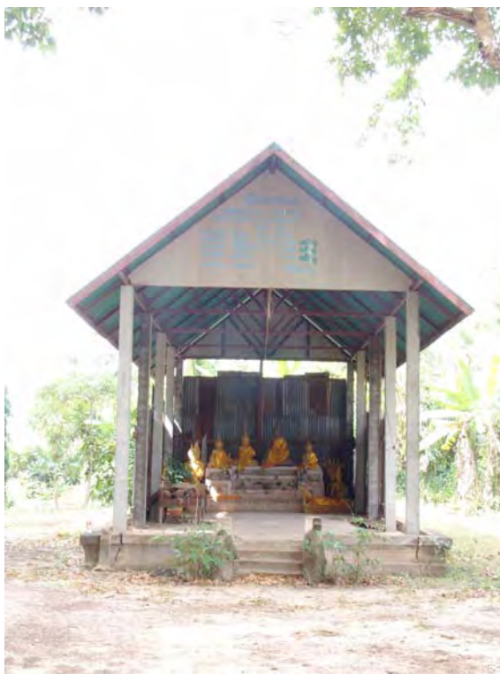
ภาพที่ 76 รูปแบบสิมโปรง เหลือเฉพาะฐาน เสาและหลังคาทำขึ้นใหม่ในปัจจุบัน ตัวอย่างที่ วัดศรีแก้ว อำเภอกุมภวาปี จังหวัดอุดรธานี
