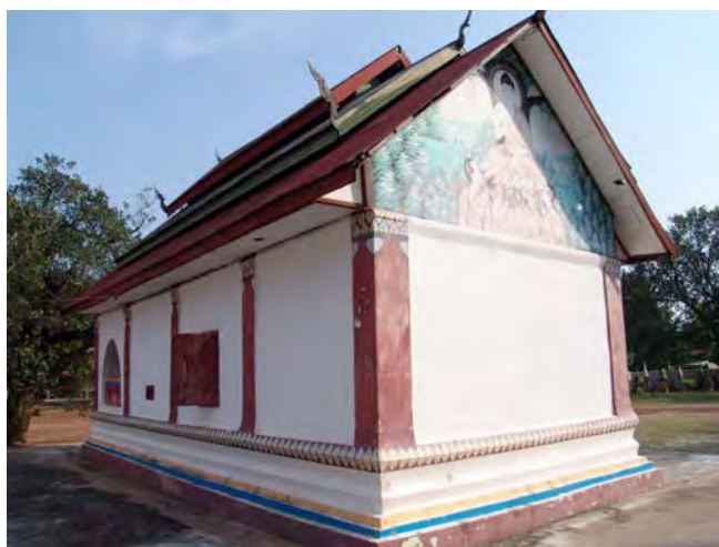
ภาพที่ 100 แสดงภาพด้านหลังผนังก่อที่บปหล่อไล่ ที่วัดโนนสว่าง บ้านดงยาง ตำบลบ้านแดง อำเภอพิบูลย์รักษ์ จังหวัดอุดรธานี
