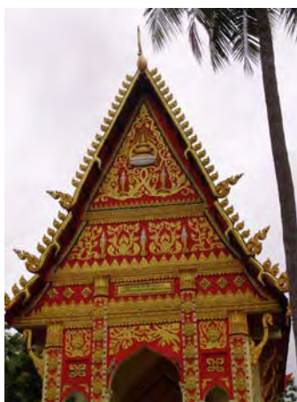
ภาพที่ 436 ตัวอย่างโครงสร้างหน้าบัน ที่วัดสุวรรณสาละวัน อำเภอเมือง จังหวัดหนองคาย
