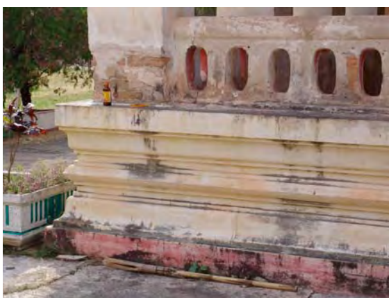
ภาพที่ 105 ภาพฐานบัวลูกแก้วอกไก่ และพนักระเบียงลูกกรงเจาะช่องรูปไข่แนวตั้ง รูปแบบเฉพาะ ฝีมือช่างญวน ที่วัดพระแท่น บ้านแดง ตำบลบ้านแดง อำเภอพิบูลย์รักษ์ จังหวัดอุดรธานี
