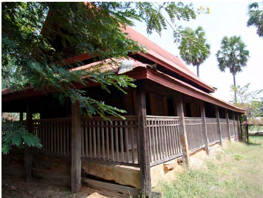
ภาพที่ 236 สิมทึบโครงสร้างผนังไม้สืบทอดรูปแบบจากสิมโปร่ง ที่วัดโนนพระ อำเภอกุมภวาปี จังหวัดอุดรธานี
