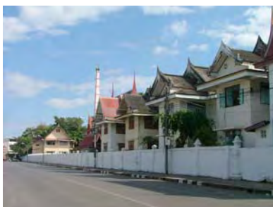
ภาพที่ 58 แสดงภาพกุฏิ ที่วัดมัชฌิมาวาส อำเภอเมือง จังหวัดอุดรธานี ซึ่งสร้างติดติดขอบรั้ววัด มีทั้งโครงสร้างไม้ และคอนกรีต
