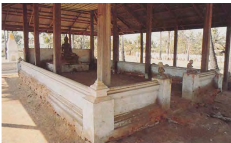
ภาพที่ 72 แสดงฐานและระเบียง เสาและหัวเสา วัดทุ่งสว่างปะโค ก่อนการบูรณะ (ภาพถ่ายเก่า) ที่มา : วิโรฒ ศรีสุโร, ลิมอีสาน (กรุงเทพฯ : เมฆาเพรส), 2536, 11.
