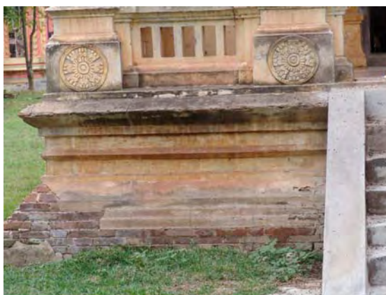
ภาพที่ 238 รูปแบบฐานบัวลูกแก้วอกไก่อิทธิพลจากฝั่งลาว ที่ช่างญวนนิยมใช้ในการก่อสร้าง ตัวอย่างที่วัดโคธาราม อำเภอบ้านผือ จังหวัดอุดรธานี
