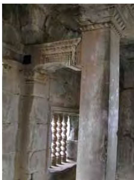
ภาพที่ 234 โครงสร้างเสาและคานภายในมณฑปปราสาทปัตตเวีย
