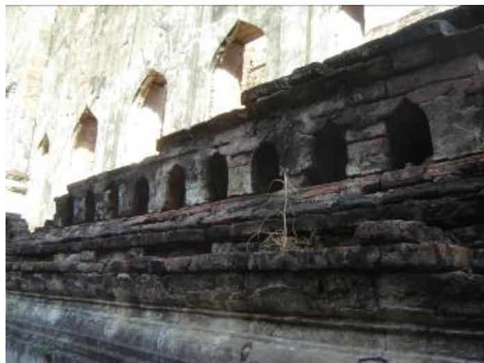
ภาพที่ 50 ช่องรูปกลีบบัวที่พนังกำแพงพระที่นั่งดุสิตสวรรค์ธัญมหาปราสาท คงสร้างในสมัยสมเด็จพระนารายณ์ พนักระเบียงฐานประทักษิณของปราสาทประธานวัดวรเชตุเทพ บารุณมีรูปแบบที่คล้ายคลึงเช่นนี้อาจเกิดจากการซ่อมสร้างเพิ่มเติมในช่วงเวลาเดียวกันนี้
