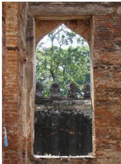
ภาพที่ 38 การก่ออิฐวงโค้งยอดแหลมหรือรูปกลีบบัวในสมัยสมเด็จพระนารายณ์เมื่อมองจากด้านใน พระที่นั่งดุสิตสวรรค์ธัญมหาปราสาทภายในพระนารายณ์ราชนิเวศน์ ลพบุรี
