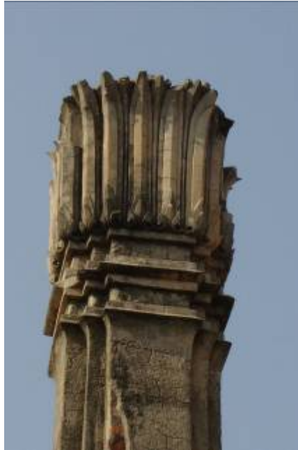
ภาพที่ 239 เสาของมุขโถง อุโบสถวัดกุฎีดาว อายุกลางพุทธศตวรรษที่ 23 เป็นเสาเหลี่ยมย่อมุมซึ่งนิยมสร้างกันในสมัยอยุธยาตอนปลาย
