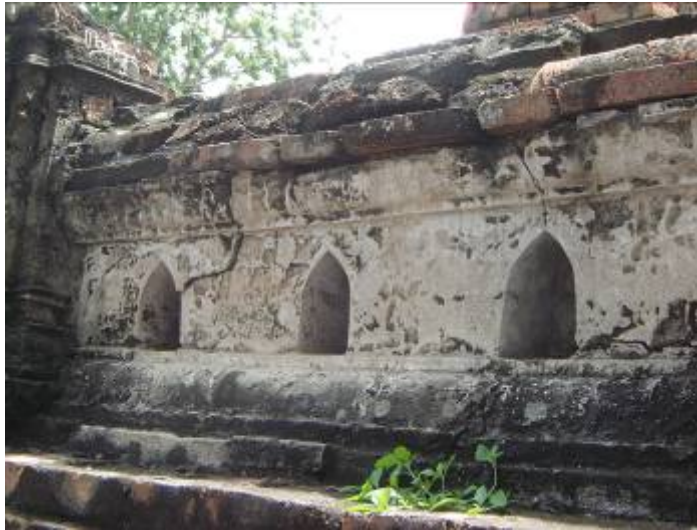
ภาพที่ 49 พนักระเบียงบนฐานประทักษิณ เจาะช่องรูปกลีบบัวขนาดเล็กเรียงกัน เข้าใจว่าคงเป็นช่องเพื่อตามประทีป
