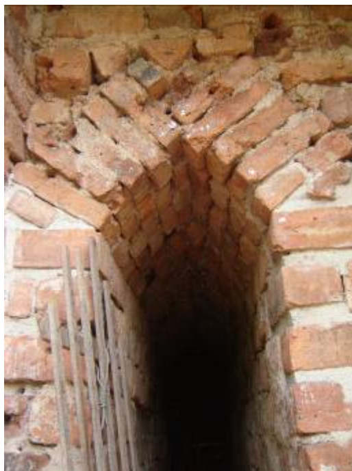
ภาพที่ 35 ทางเข้าคูหาด้านทิศตะวันออกของปราสาทประธานวัดวรเชตุเทพบำรุง มีการก่ออิฐวงโค้งยอดแหลมที่เฉียงขึ้นไปบรรจบกันที่ยอด ต่างจากที่คุ้นเคยกันในงานช่างของอยุธยา
