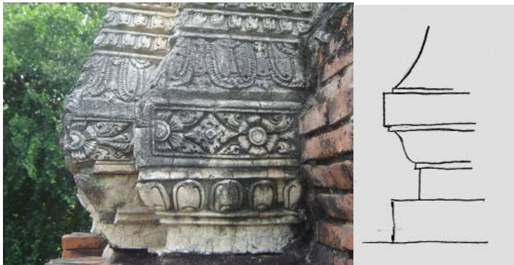
ภาพที่ 60 ฐานเชิงบาตรของปราสาทวัดส้ม เป็นบัวหงายและท้องไม้
