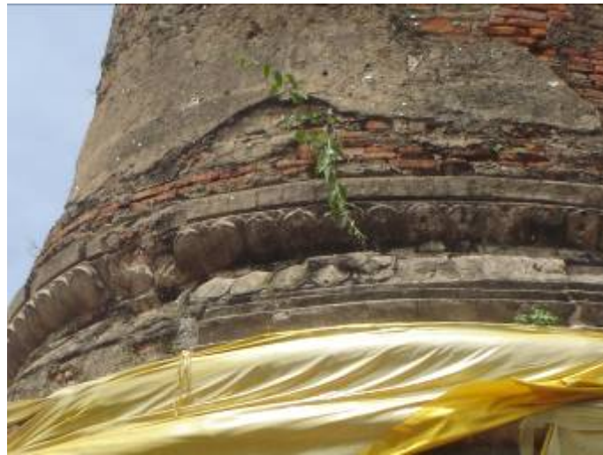
ภาพที่ 210 บัวปากระฆัง เจดีย์ทรงระฆังวัดวรเชตุเทพบารุง
