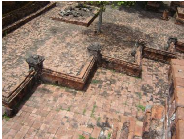
ภาพที่ 47 ฐานหรือลานประทักษิณของปรางค์ประธานวัดวรเชตุเทพบํารุง อยู่ในผังเพ็ญมุมไม้ยี่สิบ มีพนักกระเปียงและเสาหัวเม็ดทรงมณฑปประดับ
