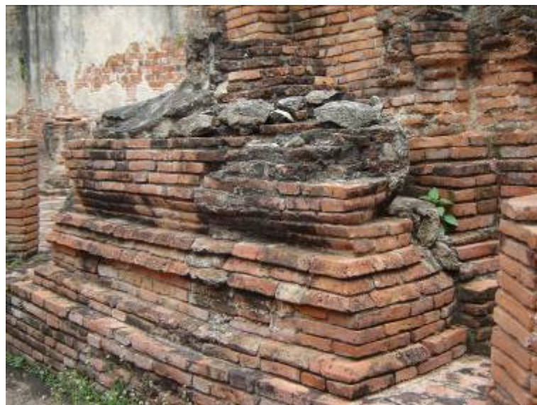
ภาพที่ 283 พระพุทธรูปปูนปั้น แกนก่ออิฐชำรุด เป็นประธานของอุโบสถวัดวรเชตุเทพบำรุง
