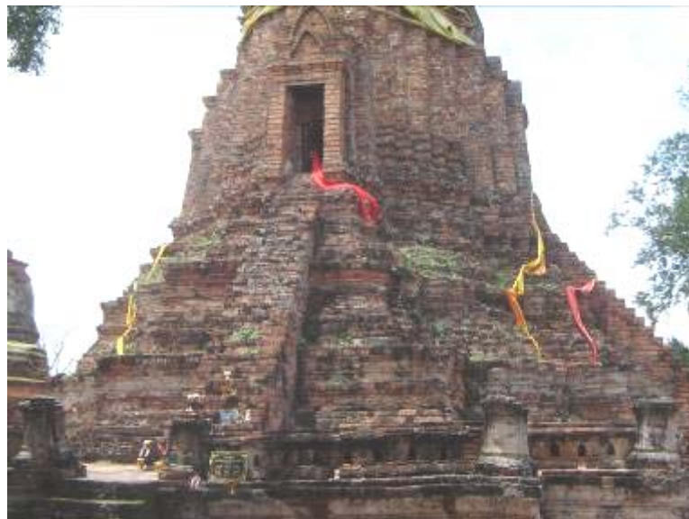
ภาพที่ 51 ฐานบัวลูกฟักสามฐานรองรับเรือนธาตุของปรางค์ประธานวัดวรเชตุเทพบำรุง
