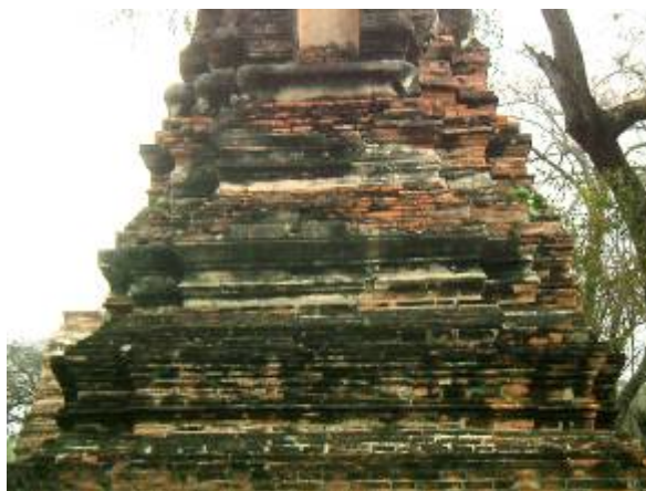
ภาพที่ 130 ชุดฐานบัวลูกแก้วอกไก่รองรับเรือนธาตุ เจดีย์หมายเลข 26 วัดพระราม
