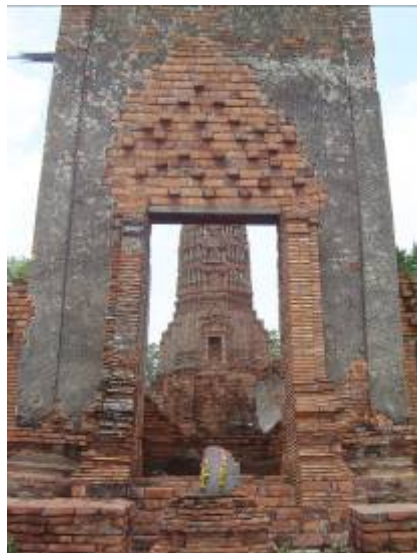
ภาพที่ 245 ซุ้มประตูของมุขด้านตะวันตกอุโบสถวัดวรเชตุเทพบำรุงเคยพังทลายและได้รับการก่อขึ้นใหม่ในการบูรณะของกรมศิลปากร
