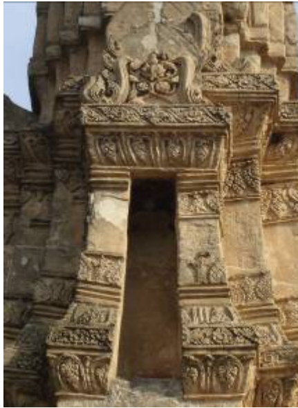
ภาพที่ 80 จระนำของปรางค์เล็กวัดโลกยสุธา ออยุธยา ศิลปะอยุธยาตอนปลายราวพุทธศตวรรษที่ 23 สังเกตได้ว่าเรือนธาตุที่เล็กลงทำให้ช่องจระนำแคบ เข้าจนไม่สามารถประดับอะไรได้เลย
