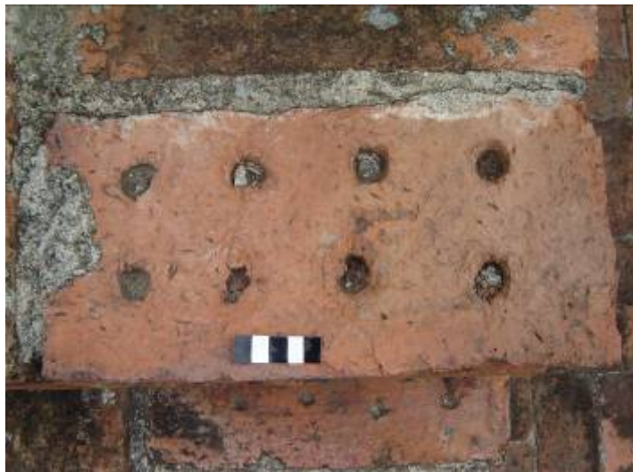
ภาพที่ 34 อิฐแปดรูที่ใช้ก่อสร้างปราสาทประธานวัดวรเชตุเทพบารุง
