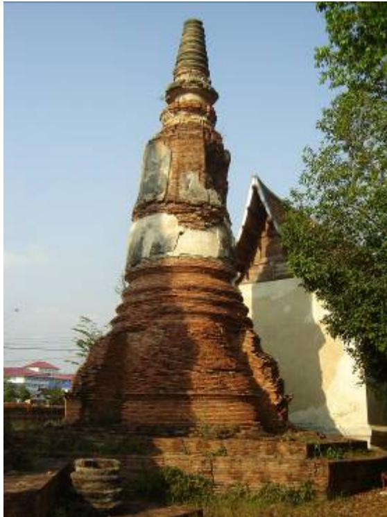
ภาพที่ 198 เจดีย์ทางทิศเหนือของวิหารหลวง วัดพุทไธสวรรย์ อยุธยา มีการสร้างเจดีย์ทรงสี่เหลี่ยมเพิ่มมุมซ้อนทับ
