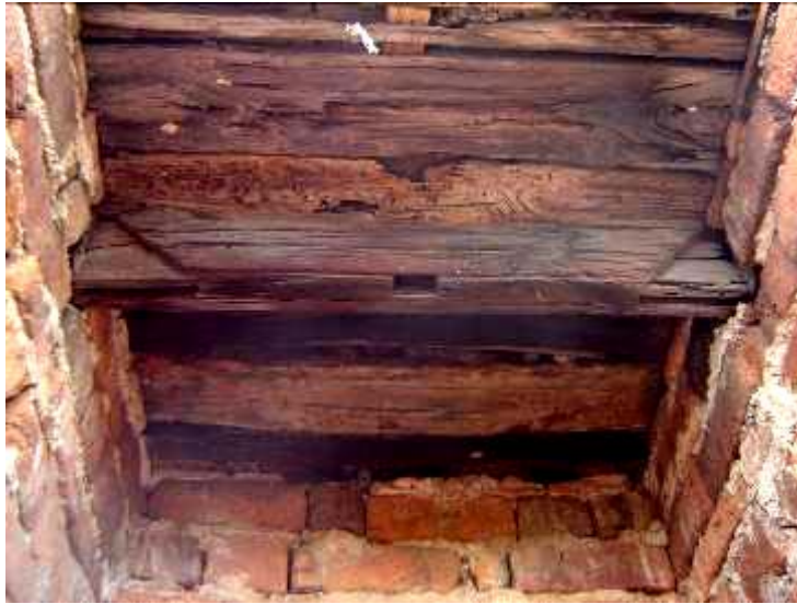
ภาพที่ 77 ซื่อและวงกบประตูไม้ของช่องจระนำทิศใต้ ปรางค์ประธานวัดวรเชตุเทพบำรุง เป็นหลักฐานว่าช่องจระนำของปรางค์ทุกด้านเคยมีการทำบานประตูมาก่อน
