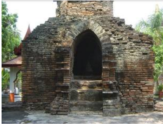
ภาพที่ 40 การก่อคูหาวงโค้งเจดีย์วัดอุโมงค์อารยมณฑล เชียงใหม่ อายุราวพุทธศตวรรษที่ 19 มีการก่อคูหาวงโค้งโดยใช้อิฐหน้าวัวเรียงต่อกันขึ้นไปบรรจบที่ยอด อัน เป็นกรรมวิธีที่ล้นนารับมาจากศิลปะพุกามของพม่า
