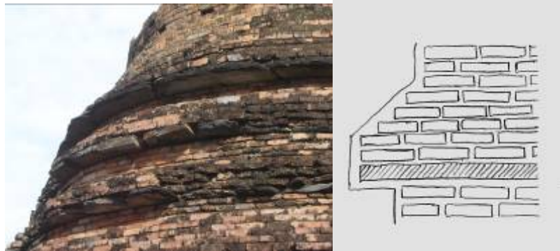
ภาพที่ 182 การก่อชุดฐานรองรับองค์ระฆังแบบ “บัวถลา” ของสุโขทัย
