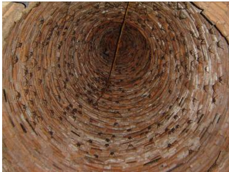
ภาพที่ 46 การก่ออิฐเป็นคูหากลวงภายในองค์เจดีย์วัดหลังคาขาว อยุธยา
