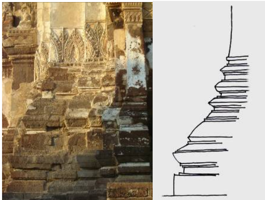
ภาพที่ 5 ลวดบัวเชิงและลวดบัวรดเกล้าของปรางค์ประธานวัดพระศรีรัตนมหาธาตุ ลพบุรี สันคิ้วลวดบัวที่ฐานหนาเกิดจากการถากศิลาแลงที่ใช้ก่อสร้างให้เป็นเส้นก่อนที่จะฉาบปูน
