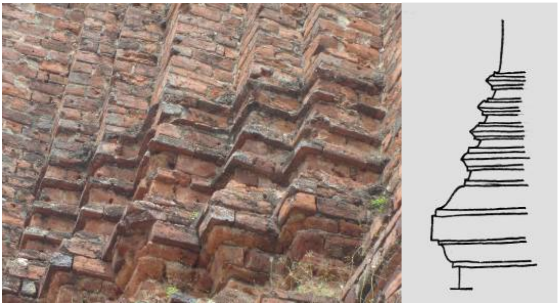
ภาพที่ 71 ลวดบัวเชิงของเรือนธาตุปราสาทประธานวัดวรมหาธาตุเทพบารุง เป็นแถบคิ้วนูนชัดเจน เกิดจากการก่ออิฐให้ยื่นพื้นแนวระนาบของเรือนธาตุและบากเป็นสันคม
