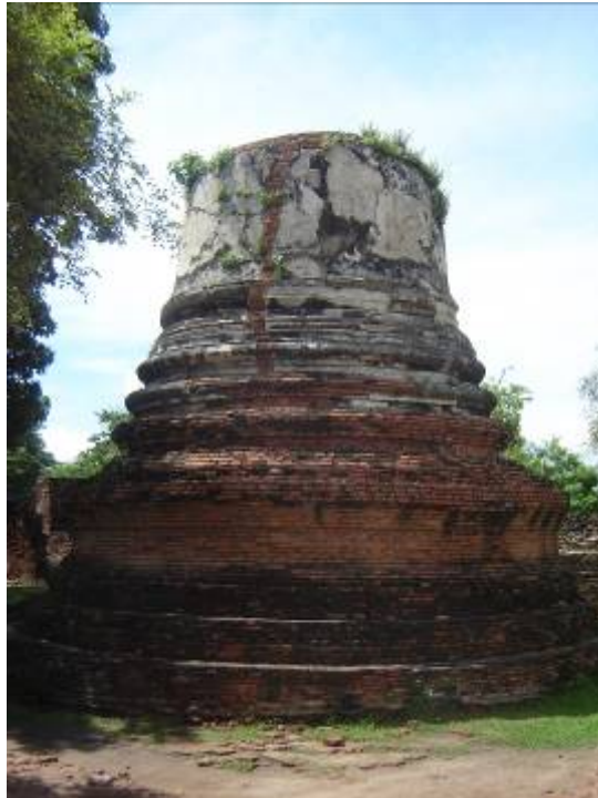
ภาพที่ 209 สุวานบัวและชุดรองรับองค์ระฆัง เจดีย์รายในวัดพระศรีสรรเพชญ์ มีรูปทรงที่ยืดยาวมากขึ้นเล็กน้อยจากสมัยอยุธยาตอนต้น
