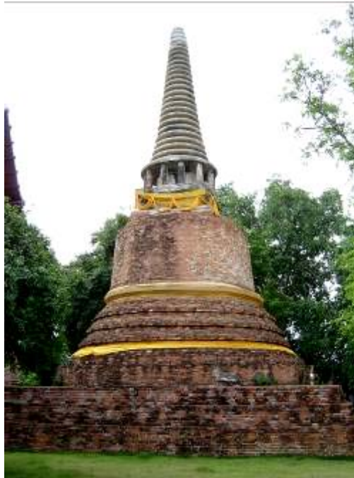
ภาพที่ 178 เจดีย์ทรงระฆังวัดสมณโกฐาราม อยุธยา อายุราวพุทธศตวรรษที่ 20 ชูตรงรับองค์ระฆังที่เป็นบัวฉลุลายพบในศิลปะสุโขทัยมาก่อน
