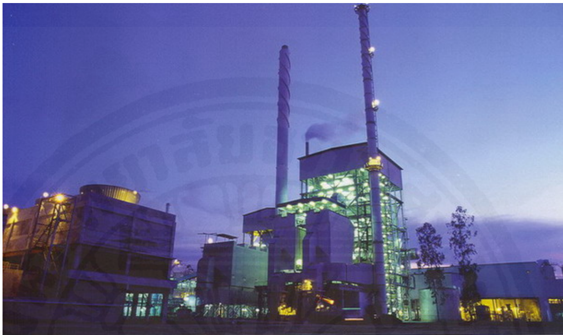
โรงไฟฟ้าพลังงานหมุนเวียนจากชีวมวล
