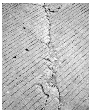
Spalling
