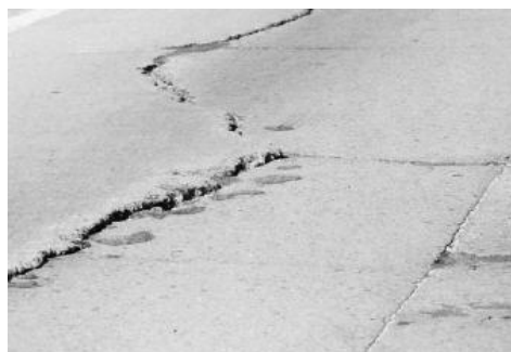
Longitudinal Crack
