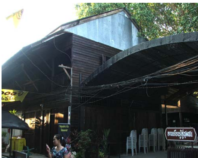
ภาพที่ 16 “บ้านป่าสายหยุด” หรือ “อาคารสายหยุด” อาคารหลังแรกที่สร้างขึ้นในตลาดสามชุก ที่มา : ภาพถ่ายจากการสำรวจพื้นที่, 16 กุมภาพันธ์ 2550
