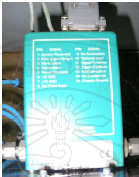
รูปที่ 3.6 อุปกรณ์ควบคุมอัตราการไหลของก๊าซไฮโดรเจนและออกซิเจน
