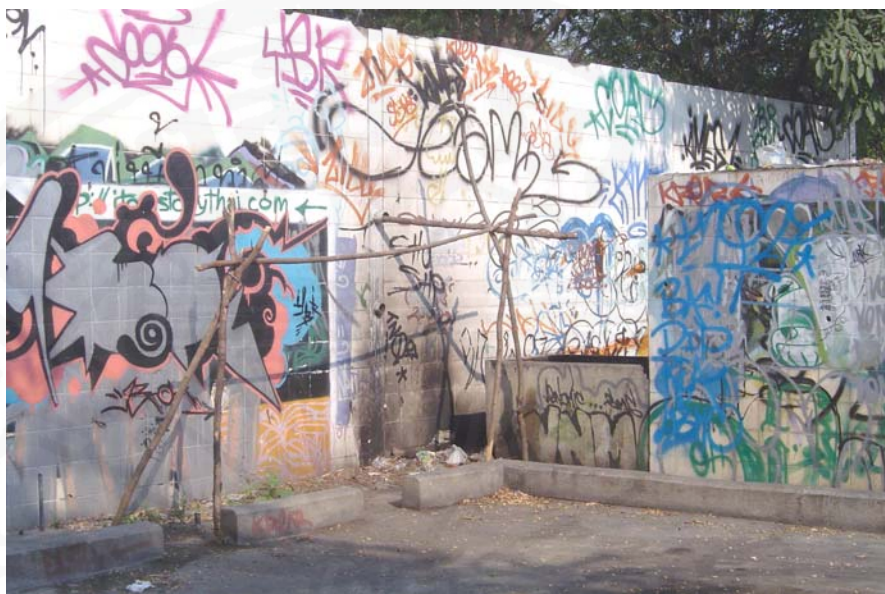
ที่มา: กำแพงร้างของปั๊มน้ำมันย่านบางเขน
