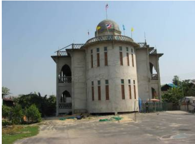
มัสยิดกันซูลญันนะห์ มัสยิดประจำชุมชน ก่อสร้างเสร็จแล้วประมาณ 60%
