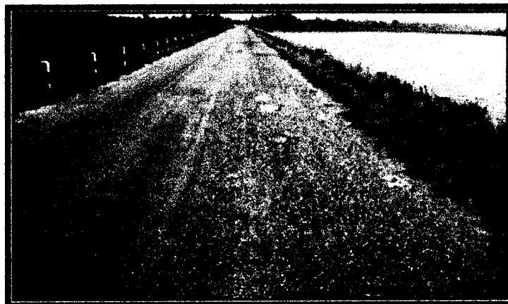
ภาพที่ 2.6 ทำนบดินอ่างเก็บน้ำห้วยลิงโจน
