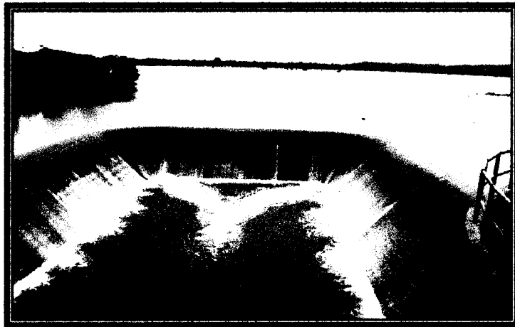
ภาพที่ 2.7 อาคารระบายน้ำล้น
