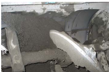
ภาพที่ จ.3(ก) ผสมคอนกรีตด้วยเครื่องผสม
