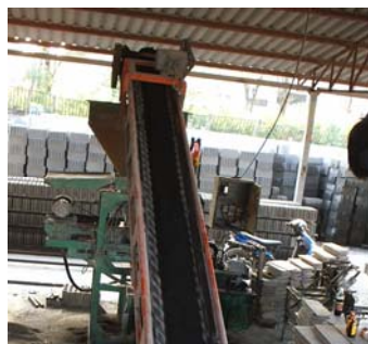
ภาพที่ จ.3(ข) การลำเลียงคอนกรีตจากเครื่องผสมมาที่เครื่องขึ้นรูป
