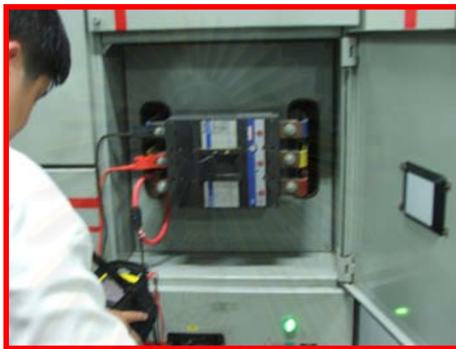
รูปที่ 3.19 แสดงการวัดค่าพลังงานไฟฟ้าที่ตู้ไฟฟ้า
