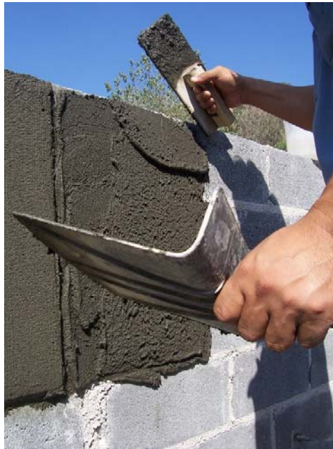
ภาพที่ ข-24 การทดสอบความสามารถใช้งานจริงโดยช่างปูน
