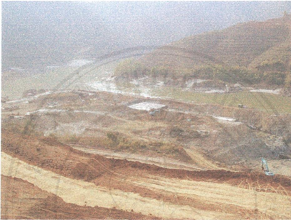
รูปที่ 7.25 เชื้อนจึงห่งที่กำลังก่อสร้าง
