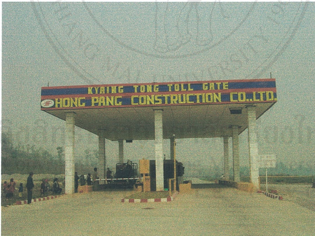
รูปที่ 7.8 ด่านเก็บค่าผ่านทาง (Toll Gate) เมืองเชียงตุง
