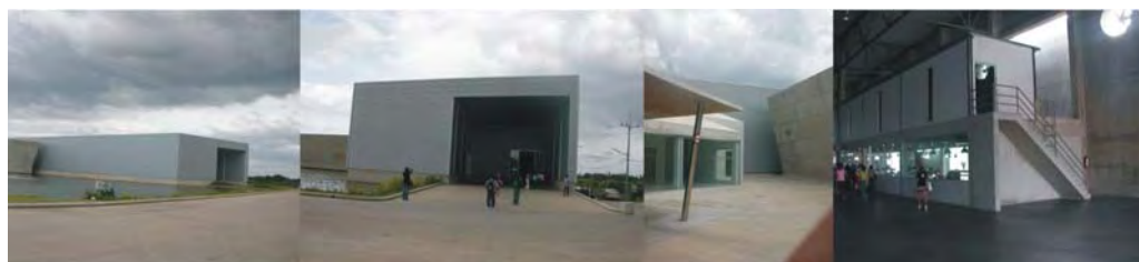
ภาพที่ 59 ทศนียภาพภายนอกและภายในอาคารโรงงานบริษัท สิ่งทอชาติน จำกัด ที่มา : จากการสำรวจของผู้วิจัย
