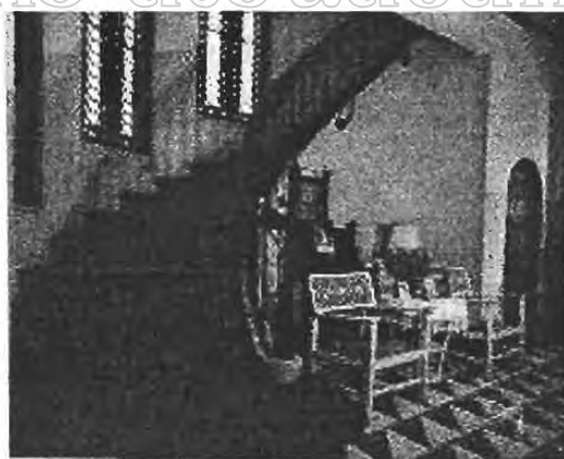
ภาพที่ 126 บริเวณโถงบ้านไคของวังวาริชเวศม์ในอดีต
