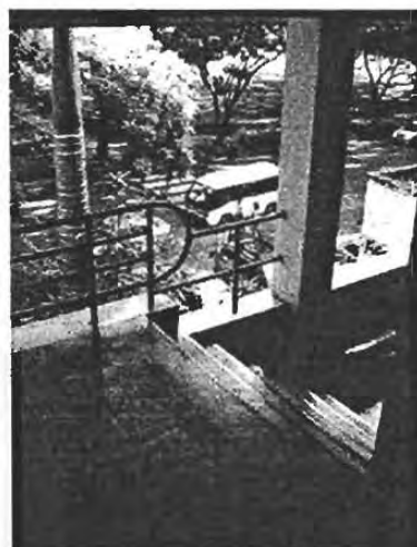
ภาพที่ 102 ทางเดินชั้น 2 อาคารเคมี 1
