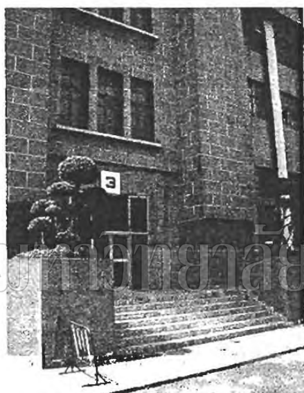
ภาพที่ 82 การแสดงแนวอิฐที่ตัวอาคารที่ทำการไปรษณีย์บางรัก
