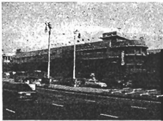
ภาพที่ 54 อาคารริมถนนราชดำเนินกลาง ในปัจจุบัน ที่มา : จากการสำรวจของผู้วิจัย
