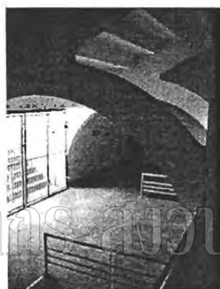
ภาพที่ 43 คานคอนกรีตโค้งรับตัวอัฒจันทร์ อาคารกรีฑาสถาน ที่มา : จากการสำรวจของผู้วิจัย
