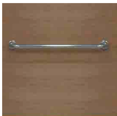
ภาพที่ 4-17 ราวจับที่ใช้ในพื้นที่ทั่วไป ใช้วัสดุเป็นสแตนเลส
