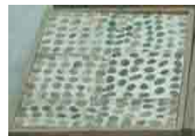
ภาพที่ 4-5 พื้นคอนกรีตตัวหนอน
