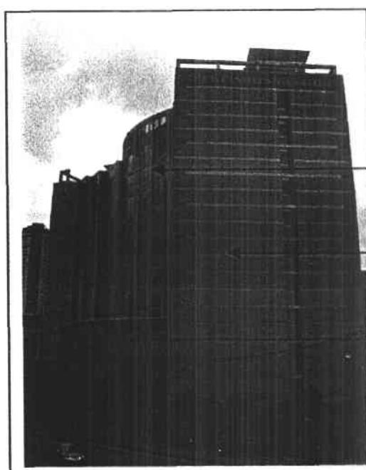
รูปอาคารหลังการปรับปรุงเปลือกอาคาร
