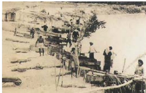
การทำเหมืองแร่แบบดั้งเดิมคือแบบเหมืองหาบ
