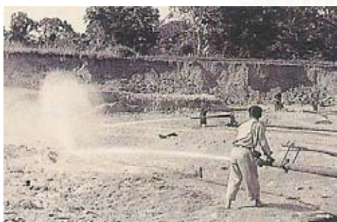
การทำเหมืองแร่แบบใหม่คือเหมืองฉีดและเหมืองสูบ
