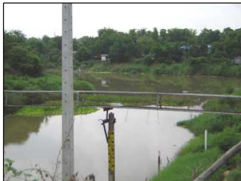
SH 01 โรงสูบน้ำเสาไห้
