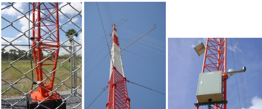
รูปที่ 3.1 เสาหลักโครงสามเหลี่ยมแบบ hot dipped galvanized พร้อมฐานราก
