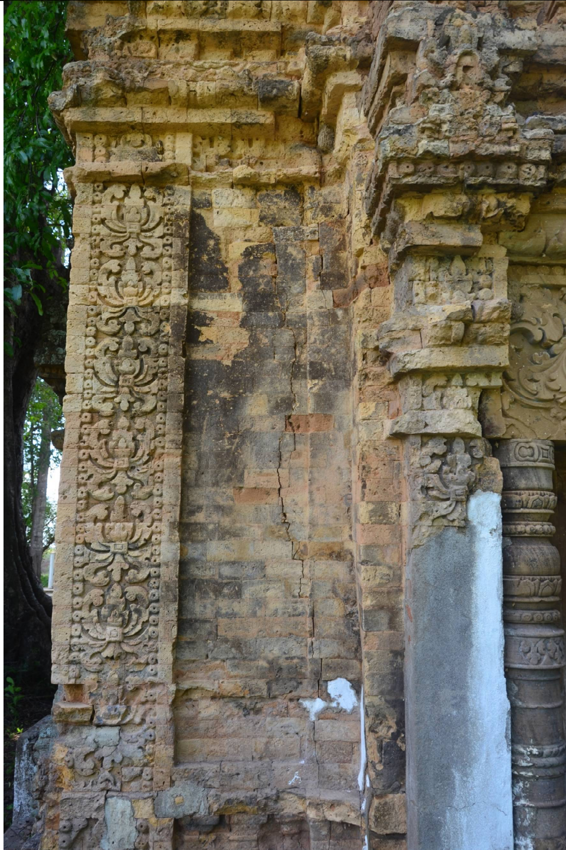
รูปที่ 4.20 เสาติดผนังของปราสาทกำพงพระ แสดงให้เห็นแถบลายประดับกลางเสาสมัยก่อนเมืองพระนคร
