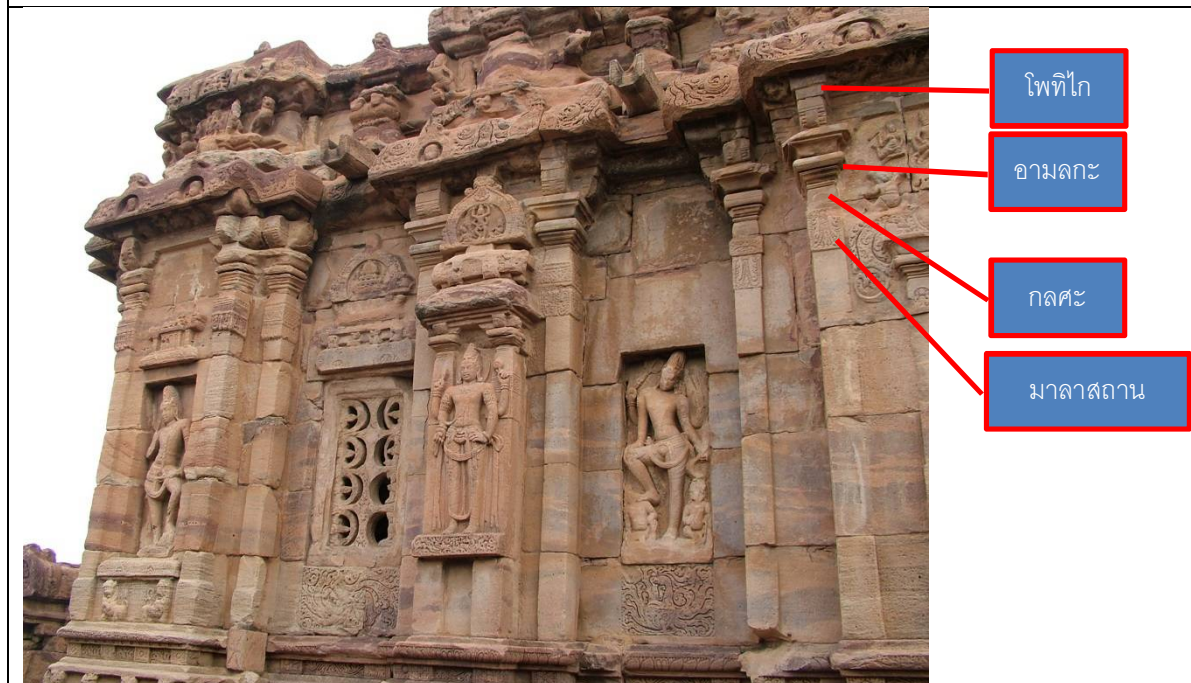
รูปที่ 4.8 เสดิผนังของเทวาลัยวิรูปักษ์ เมืองปุกกาทักล ศิลปะจาลูกยะตะวันตกระยะแรก เป็นเสาดิยนแบบเครื่องไม้ทั้งหมด
