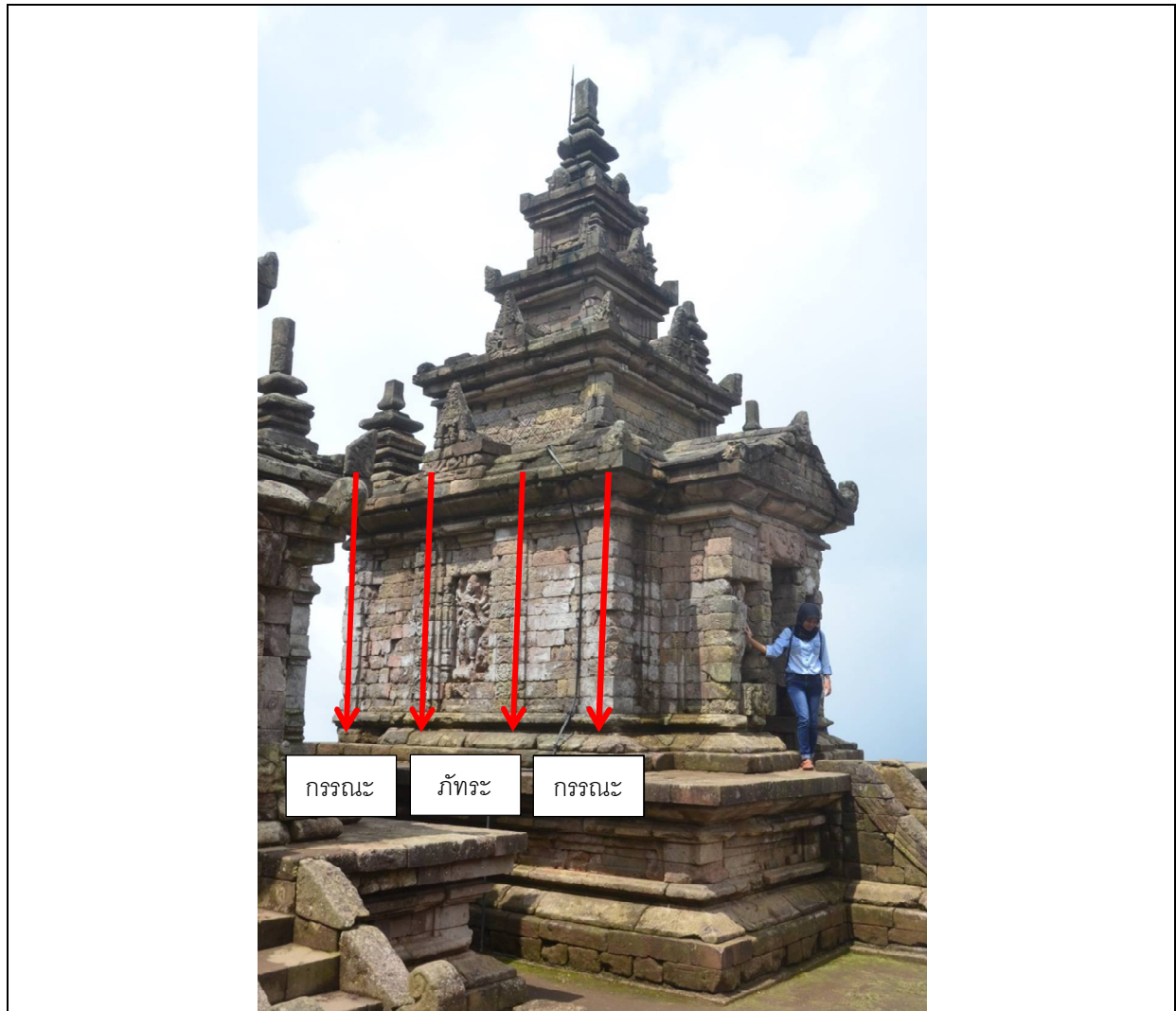
รูปที่ 4.43 เรือนธาตุของจันทิเกดงสงโง ศิลปะชาวภาคกลางตอนต้น มีการใช้เสาดัดผนังจำนวน 4 ต้นในการแบ่งเรือนธาตุออกเป็นสามเก็จตามแผนผังแบบตรีวิธะ
