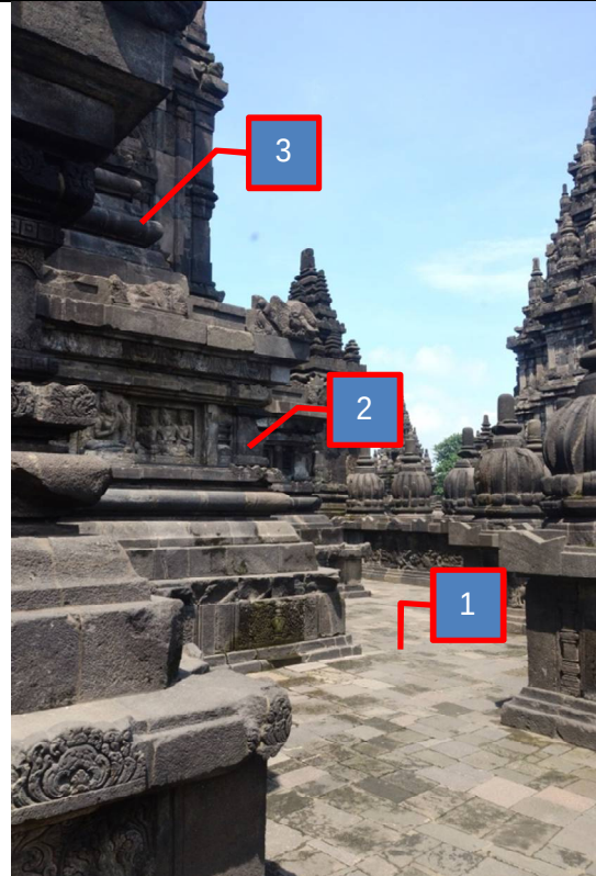
รูปที่ 3.80 ระบบฐานที่จันทิกะลาสัน สังเกตว่าปรากฏฐานประทักษิณ (หมายเลข 1) ฐานท้องไม้กว้างซึ่งหนุนปราสาทให้สูงขึ้น (หมายเลข 2) และฐานเวทีพื้นระบือนธาตุ (หมายเลข 3)
