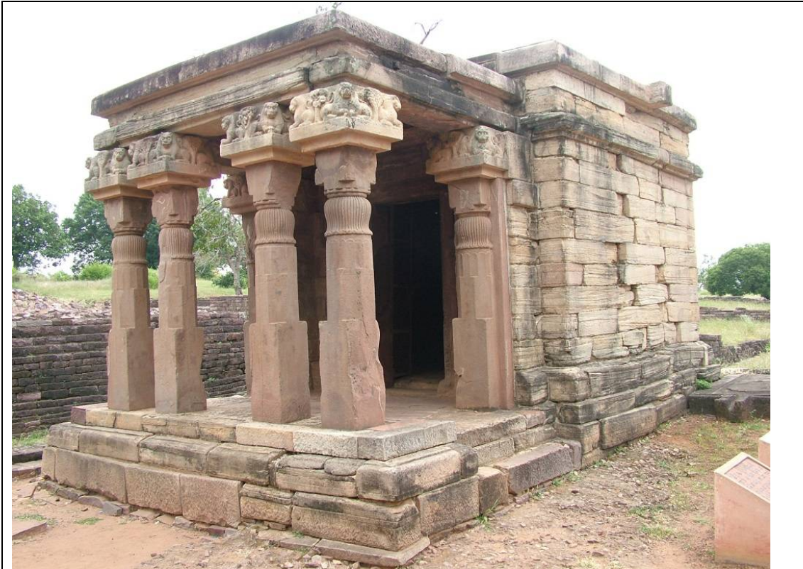
รูปที่ 2.8 อาคารหมายเลข 17 ที่สาญจี ตัวอย่างอาคารหลังคาตัดในศิลปะคุปตะ
