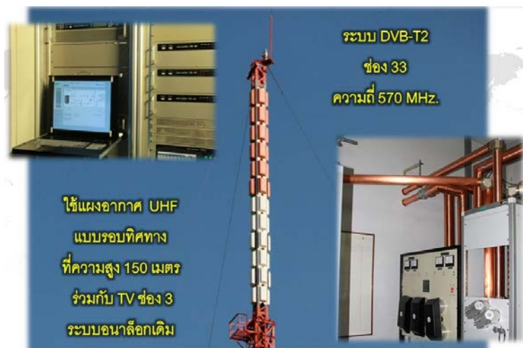
รูปที่ 2.9 การทดลองส่งสัญญาณโทรทัศน์ระบบดิจิทัล ที่สถานีโทรทัศน์ อสมท. จังหวัดสุโขทัย ( http://dtv.mcot.net/data/up_show.php?id=1379730890&web=reportdtv )
