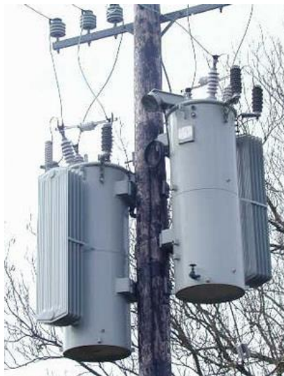
รูปที่ 2.11 LVR แบบที่มีอัตราส่วนแรงดันคงที่สำหรับติดตั้งบนเสา
