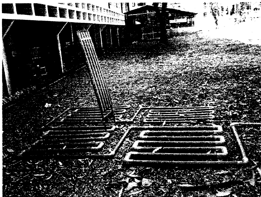
ภาพที่ 10 การติดตั้ง Multitubes Flocculator ด้านข้าง
