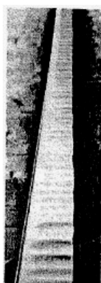
รูปที่ 4.24 การเป็นลอนลูกฟูกของราง (กิจการร่วมค้า ซีเคเอสแอล, 2545)
