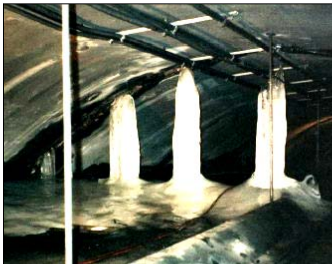
รูปที่ 2.1 การก่อตัวเป็นน้ำแข็งย่อยเหนือบีดานอุโมงค์ (FHWA และ FTA, 2003)
