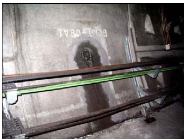
รูปที่ 4.14 การรั่วไหลของน้ำบริเวณรูฉีดยาน้ำปูน
