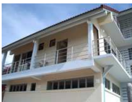
ภาพที่ 5 อาคารกตปุณณสูตร
