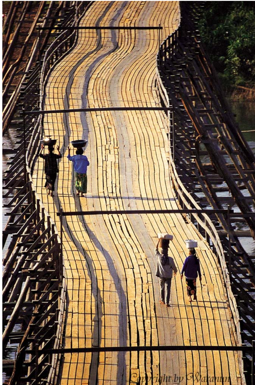
ภาพที่ 4.21 “สะพานอุตตะมานุสรณ์”
