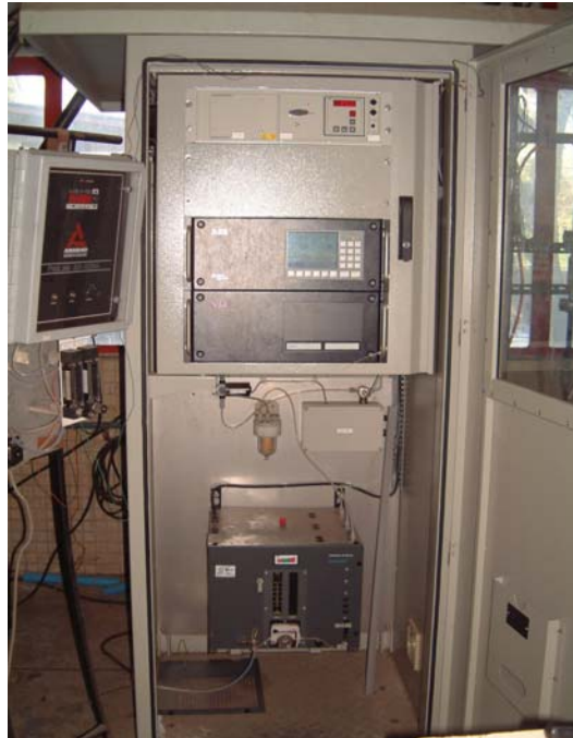
ภาพที่ 3-10 อุปกรณ์วิเคราะห์ก๊าซแบบนอลดิสเพอร์ทีฟอินฟาเรด
