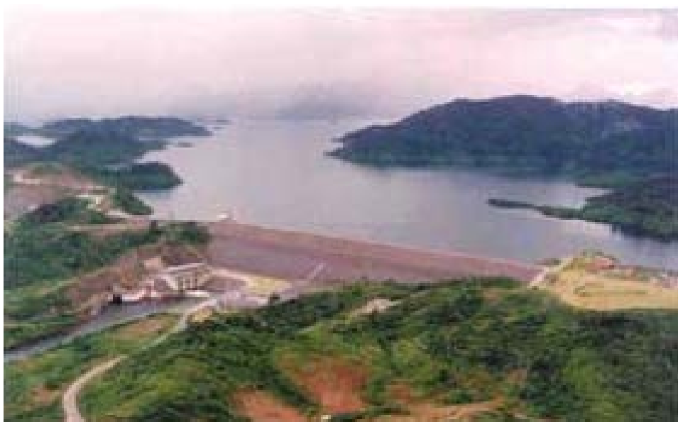
รูปที่ 2.3 เขื่อนรัชชประภา จังหวัดสุราษฎร์ธานี เป็นโครงการไฟฟ้าพลังน้ำขนาดใหญ่ [4]
