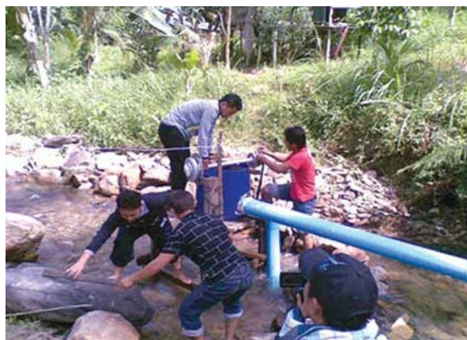
รูปที่ 2.28 การติดตั้งระบบผลิตไฟฟ้าพลังงานน้ำขนาดเล็ก [32]
