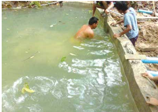
รูปที่ 2.27 การทำฝายเพื่อให้ระดับหัวน้ำสูงประมาณ 1.25 m [32]
