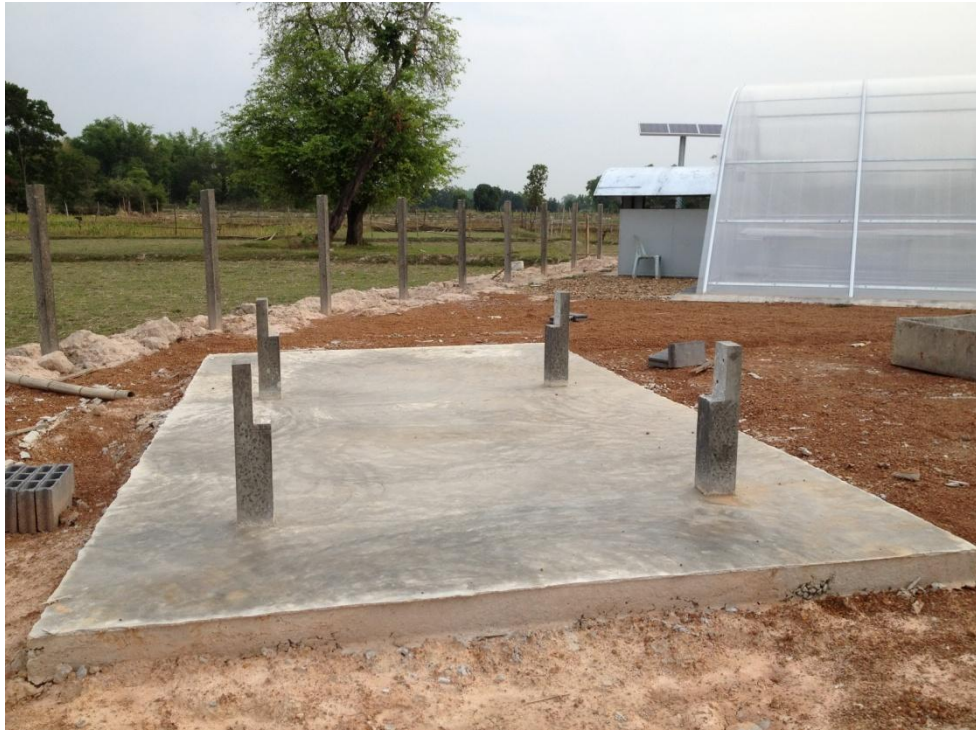
รูปที่ 3. 1 แสดงการเทพื้นด้วยคอนกรีต
