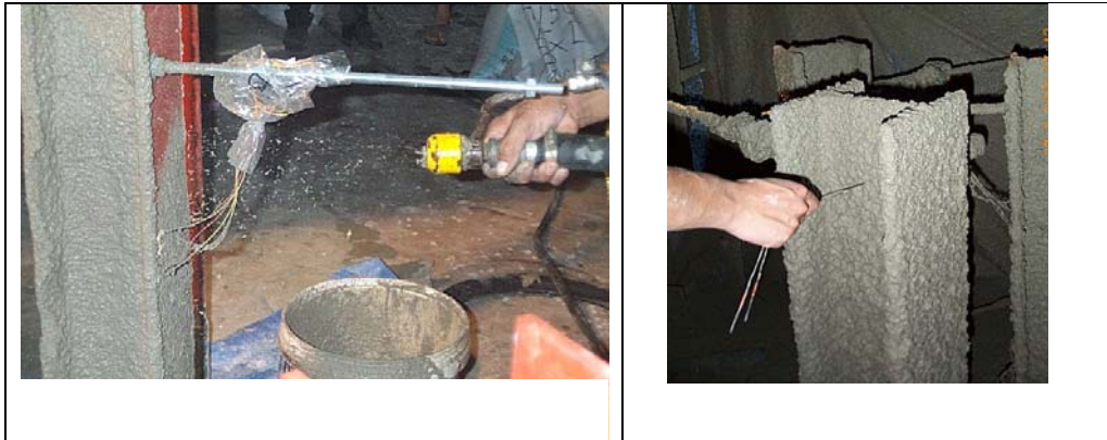
ภาพที่ 3-5 แสดงการพ่นเคลือบผิวเหล็กและตำแหน่งการวัดความหนาของวัสดุเคลือบป้องกันไฟ
