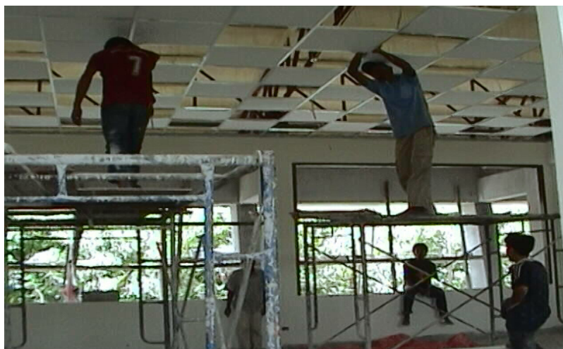
ภาพที่ 5-2 ลักษณะการทำงานของชุดติดตั้งแผ่นฝ้าที่บาร์
