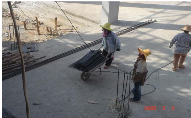
ภาพที่ 5-13 ลักษณะการจัดการขนส่งเหล็กเสริม
