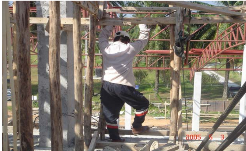
ภาพที่ 5-12 ลักษณะงานไร้ประสิทธิผลของช่างคนที่2 งานติดตั้งเหล็กเสริม
