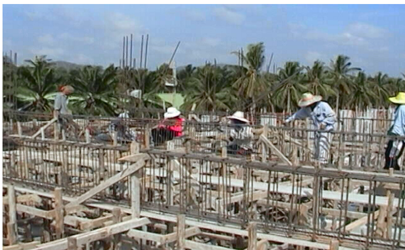
ภาพที่ 5-10 ลักษณะของการทำงานชุดติดตั้งเหล็กเสริม
