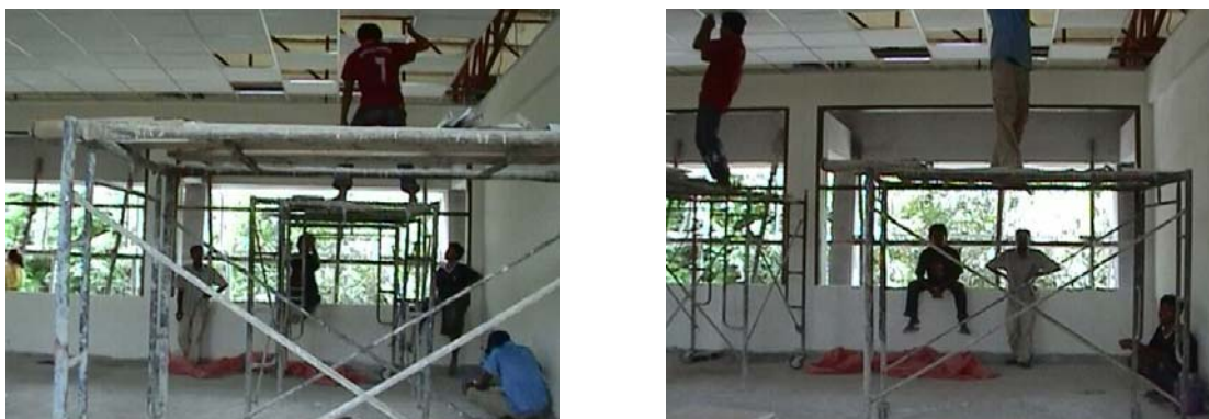
ภาพที่ 5-3 ลักษณะของงานไร้ประสิทธิผลของชุดคนงานติดตั้งแผ่นฝ้าที่บาร์
