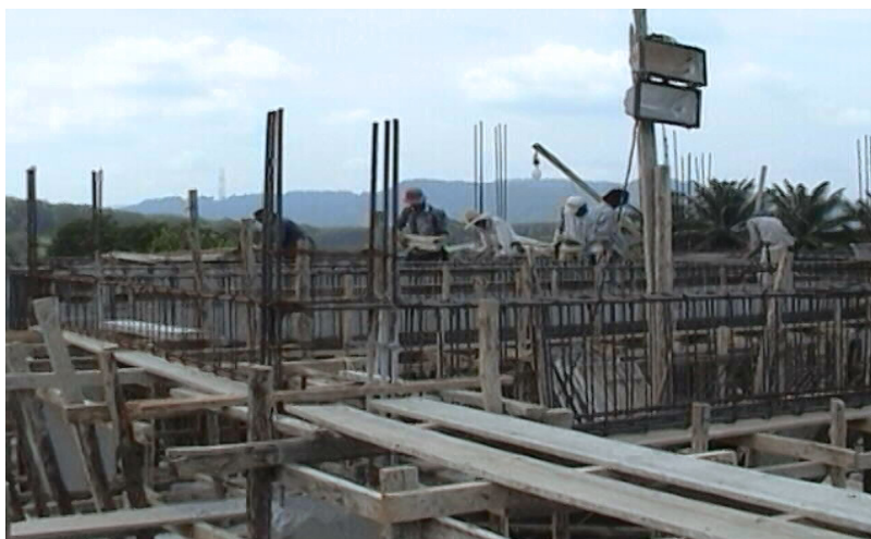
ภาพที่ 5-8 ลักษณะของการทำงานชุดติดตั้งไม้แบบ
