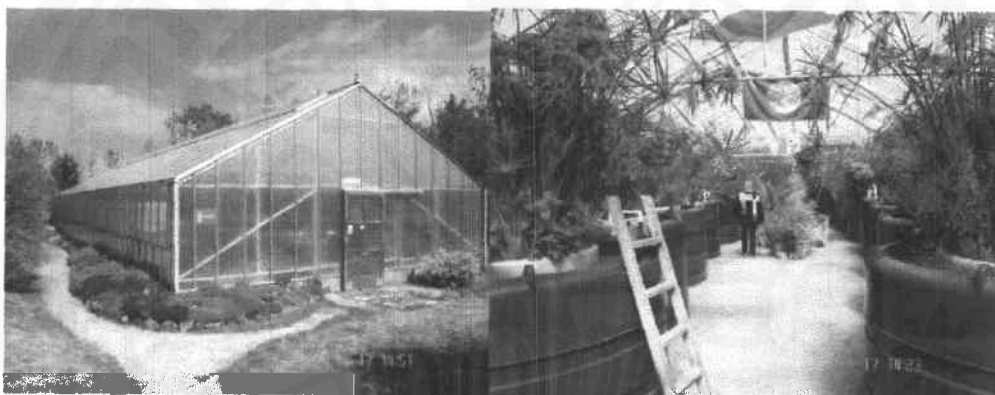
โรงบำบัดน้ำเสียธรรมชาติ ("เครื่องกลที่มีชีวิต") โดยปล่อยน้ำเข้าให้พืชในถังดูดซับของเสีย
