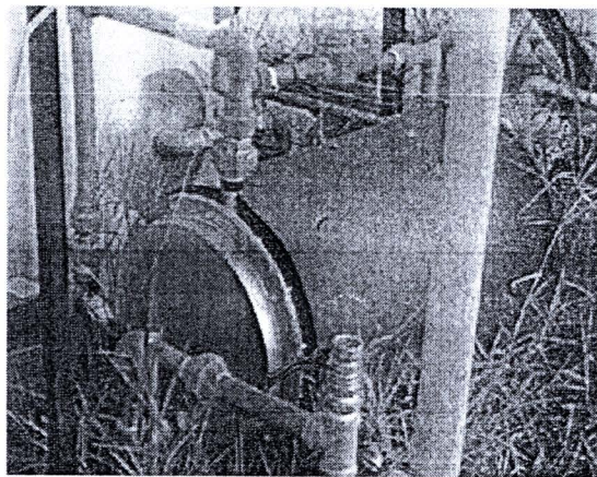
รูปที่ 3.7 อุปกรณ์แลกเปลี่ยนความร้อนแบบ Shell & Tube
