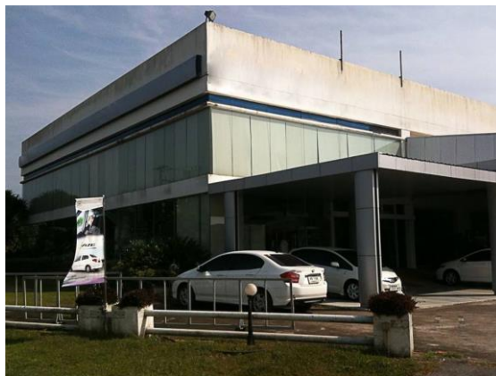
รูปที่ 4.1 ลักษณะอาคารโชว์รูมรถยนต์
