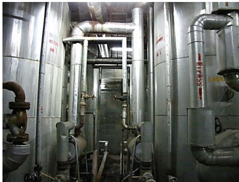
รูปที่ 3.9 หม้อต้มน้ำ Calorifier ขนาด 8,000 ลิตร จำนวน 4 ชุด
