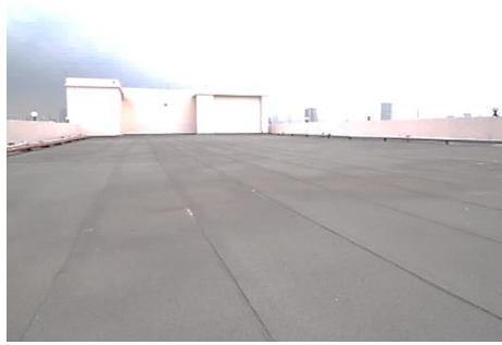
รูปที่ 3.11 บริเวณพื้นที่ที่จะใช้ติดตั้งเครื่องปั๊มความร้อนและถังเก็บน้ำร้อน
