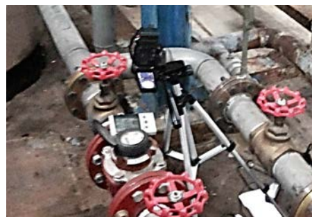
รูปที่ 3.12 การติดตั้งเครื่องตรวจวัดอุณหภูมิน้ำป้อน และบันทึกปริมาณน้ำป้อนหม้อไอน้ำ
