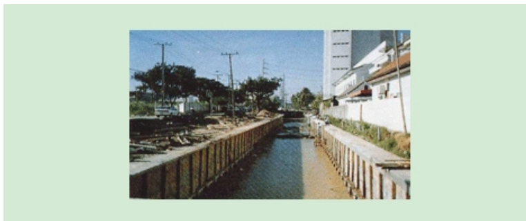
รูปที่ 2.1 แสดงเขื่อนแบบค้ำยันกลาง
