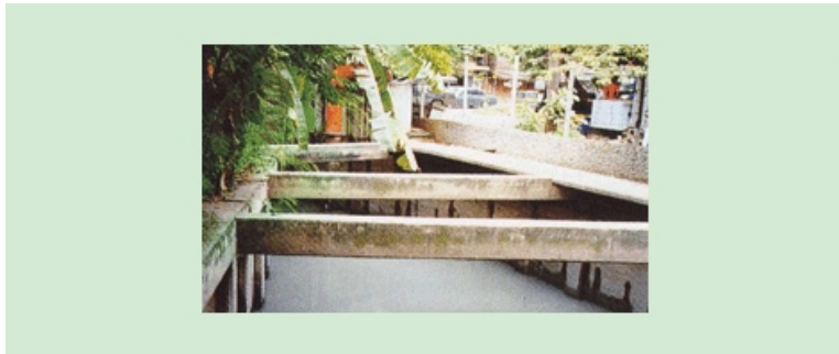
รูปที่ 2.1 แสดงเขื่อนแบบค้ำยันกลาง
