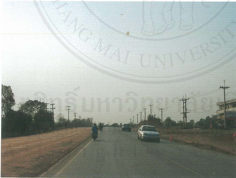
รูป 4 การขยายช่องทางจราจรเพิ่มเติมจากเดิม (กำลังดำเนินการก่อสร้างในปัจจุบัน)
